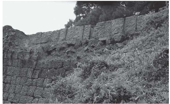
(b) 崩落した壁石と通水管
