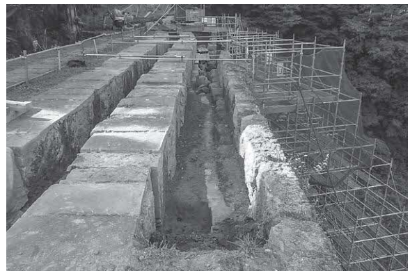
写真4-3-1. 被覆土掘削完了
