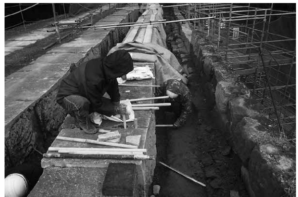
写真4-5-2. 目地漆喰詰め込み
