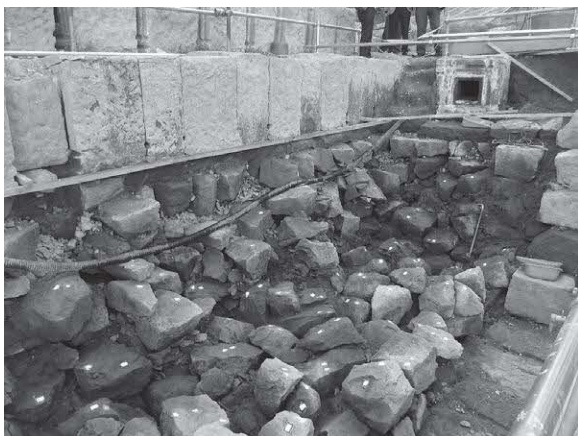
(a) 解体後の裏込め石と壁石の状況
