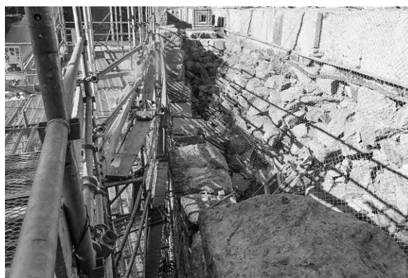
写真4-4-9. 吹上口側仮組②横断方向 (10月10日時点)
