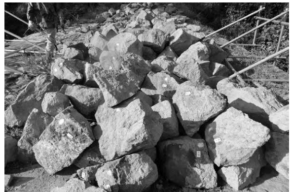
写真5-2-1. 解体した裏築石（橋上で一時保管）
