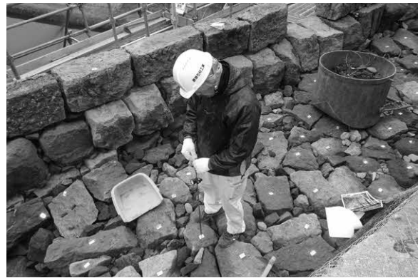
写真4-4-13. 裏築天端石復旧
