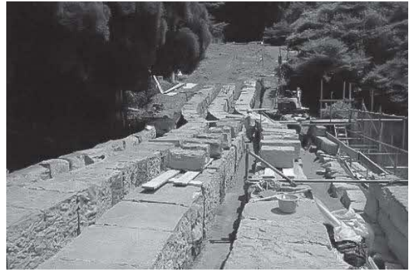
(b) 手摺石の補修工事
