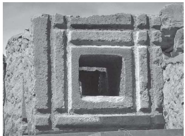
(b) 通水石管の断面状況
