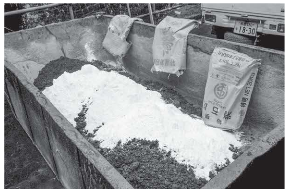
写真4-3-2. 消石灰混ぜ合わせ
