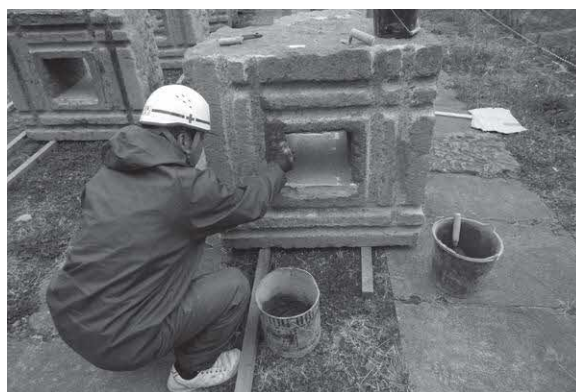
写真4-4-5. 目地孔亀裂補修
