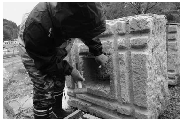
写真4-5-1. 目地漆喰除去
