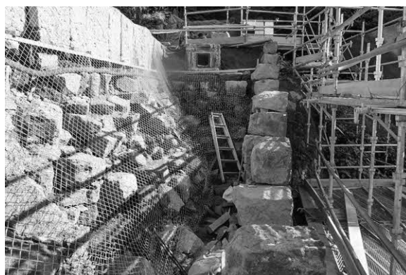
写真4-4-8. 吹上口側仮組②縦断方向 (10月10日時点)
