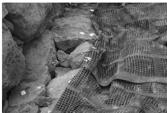
写真4-4-15. ジオテキスタイルの緊結
