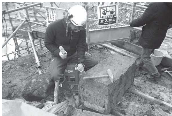
写真4-4-6. 手摺石の取り替え
