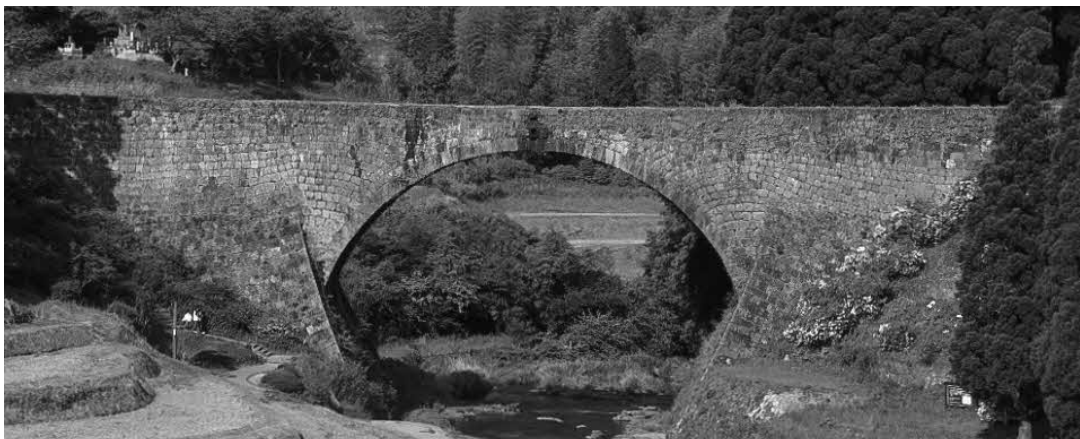
写真-1. 被災前の通潤橋の本体正面の様子
