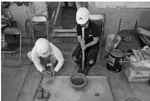
写真3-5-9. 試験体目地漆喰詰め込み
