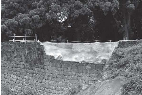
写真4-1-5. モルタル被覆養生及び支保工設置
