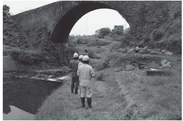
写真4-1-7. 崩落石材の回収
