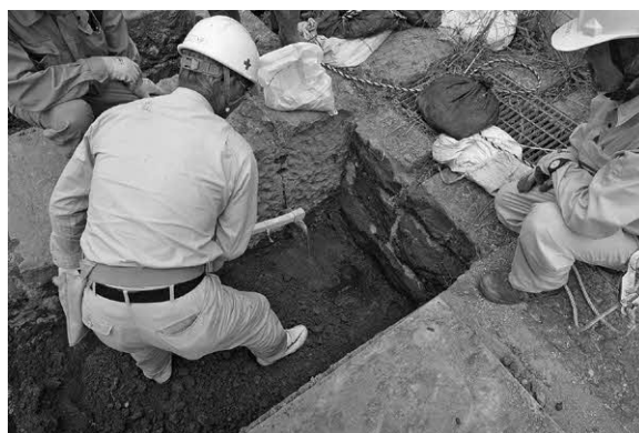
写真3-3-1. 被覆土掘削
