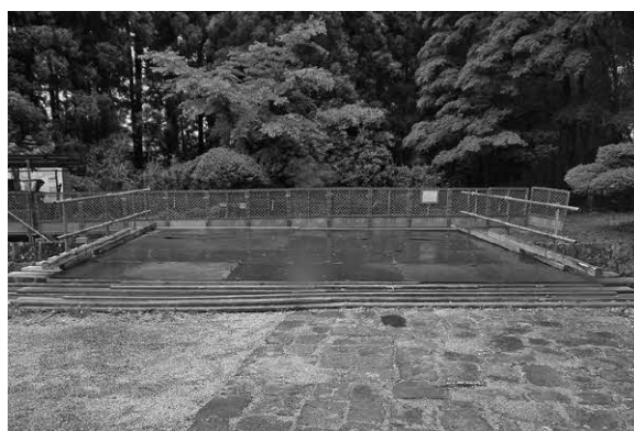
写真3-2-2. 吹上ロステージ設置完了
