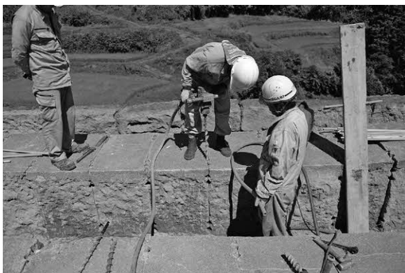
写真3-5-4. 目地漆喰除去
