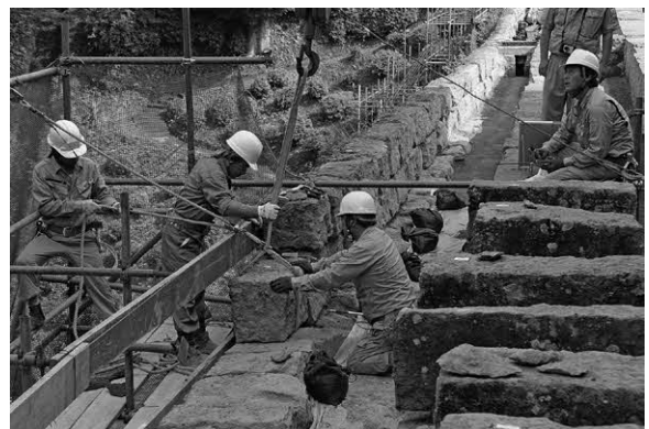
写真3-4-6. 手摺石据え直し
