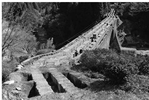
写真3-3-3. 被覆土掘削完了
