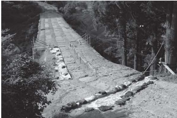
写真4-1-6. 支保工と土のうの設置
