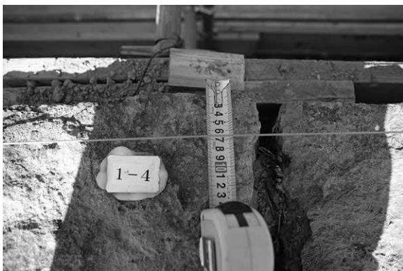
写真3-4-2. 手摺石の孕み出し確認
