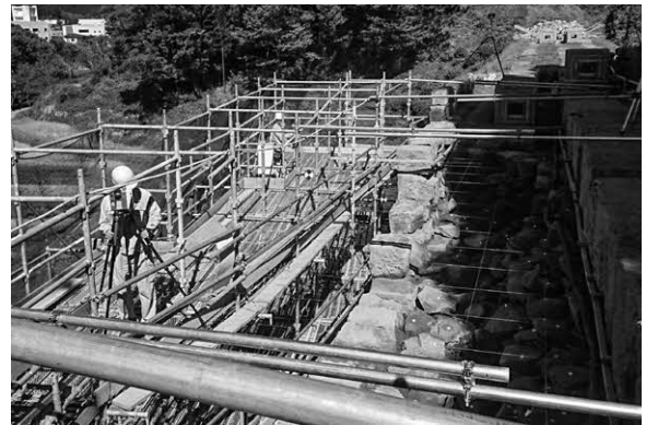
写真4-1-13. 3次元レーザ測量の状況
