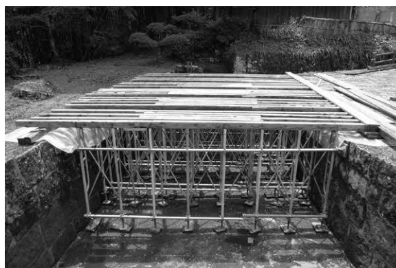
写真3-2-1. 吹上ロステージ設置
