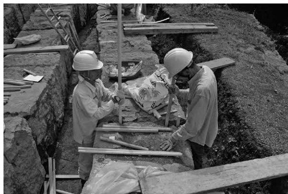
写真3-5-8. 漆喰を詰め込む
