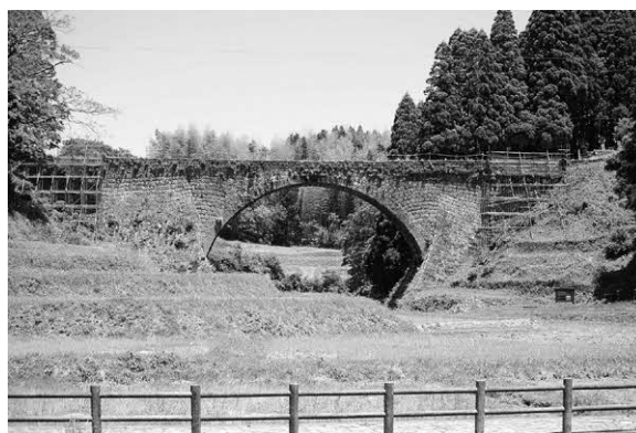
写真3-2-4. 直接足場架設完了
