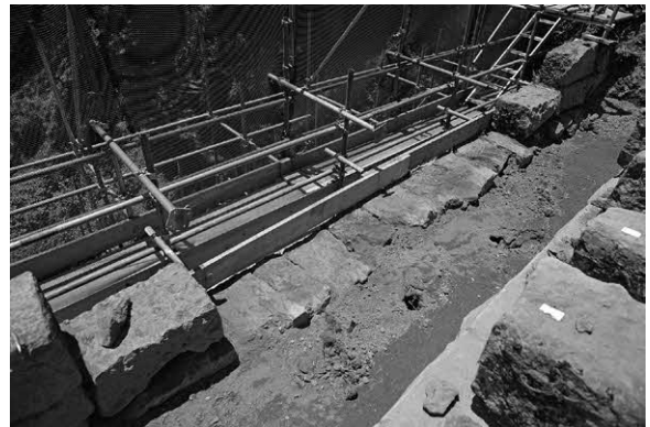
写真3-4-5. 手摺石取り外し完了
