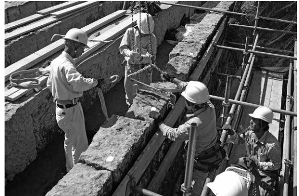
写真3-4-3. 手摺石取り外し
