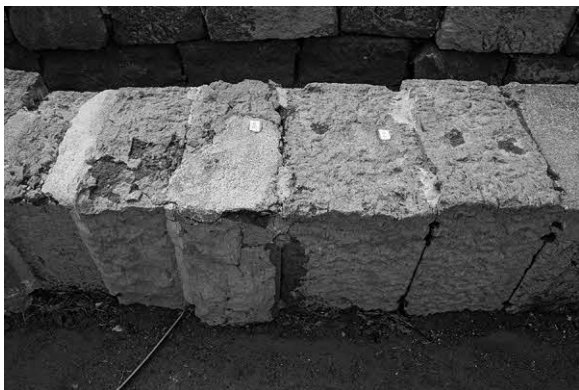
写真3-5-3. 通水試験（石管から水が染み出している）
