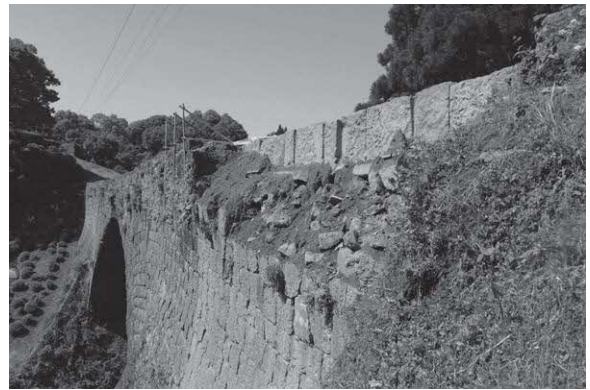
写真4-1-3. 崩落部近景
