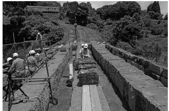
写真3-4-4. 手摺石の仮置
