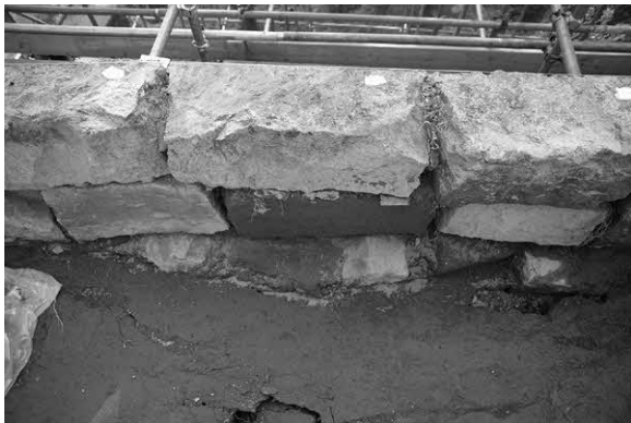
写真3-4-1. 手摺石背面側
