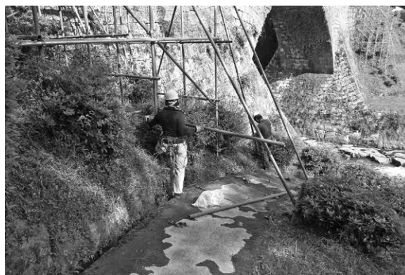
写真3-2-3. 直接足場架設
