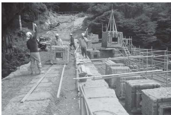
写真50. 通水石管解体状況
