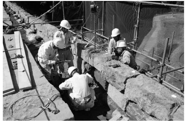
写真25. 上流左岸側手摺石解体状況
