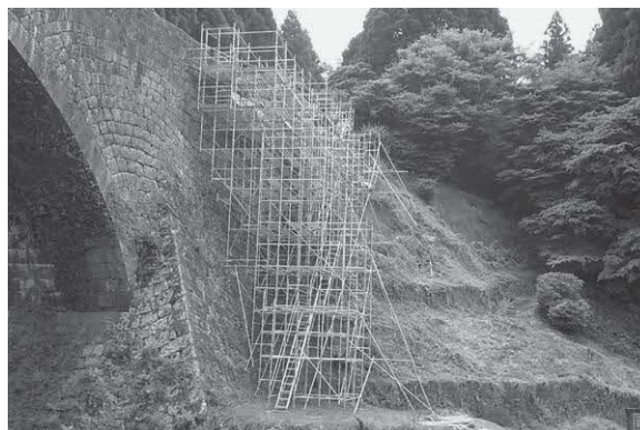
写真49. 直接足場仮設
