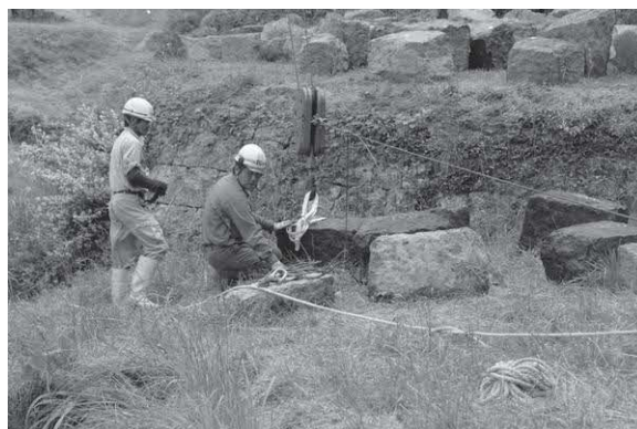
写真45. 崩落石材の回収
