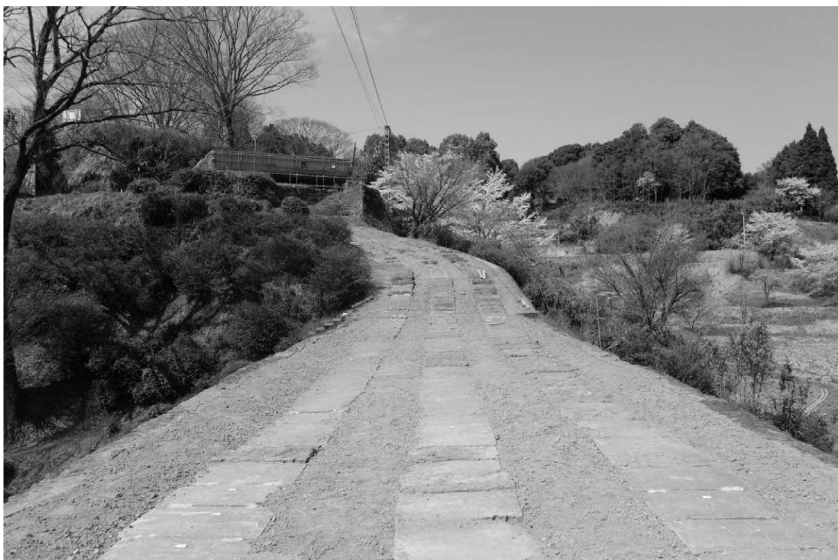
写真41. 修理後橋上被覆土埋め戻し完了（平成30年3月）
