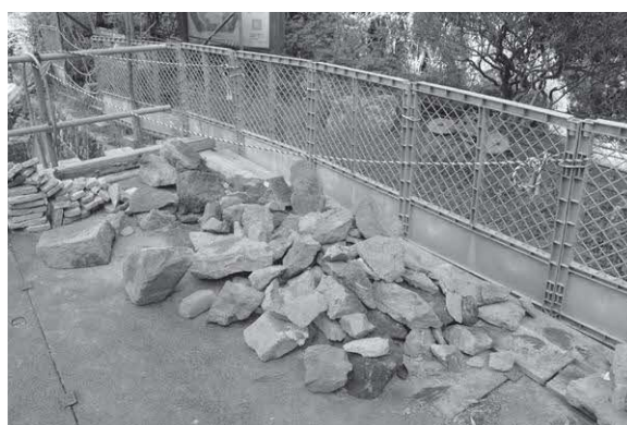
写真47. 回収した裏築石
