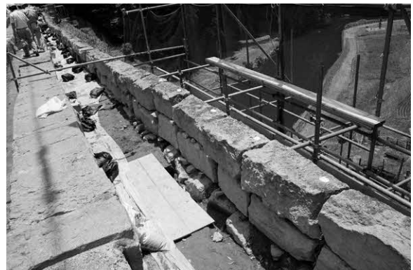
写真29. 上流左岸側手摺石据え直し完了
