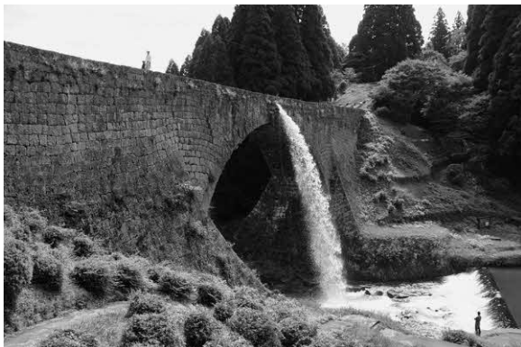
写真30. 通水試験状況
