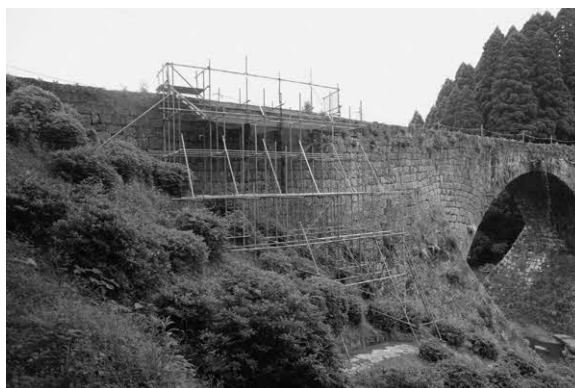
写真20. 直接足場仮設
