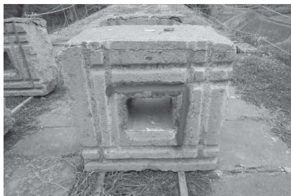
写真51. 通水石管目地孔補修
