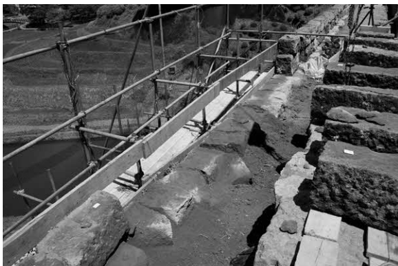
写真26. 上流右岸側手摺石解体完了
