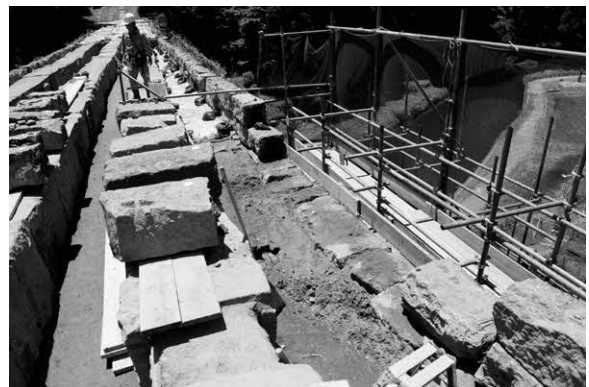
写真27. 上流左岸側手摺石解体完了
