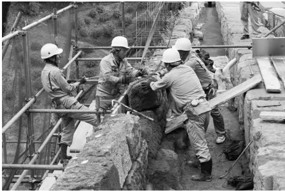
写真24. 上流右岸側手摺石解体状況
