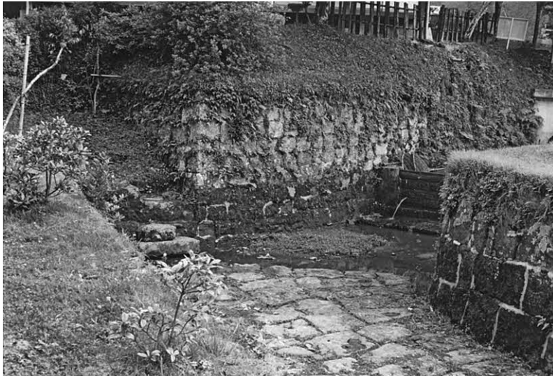
写真10. 吹上口 (昭和46年以前ヒューム管設置後) ※昭和46年修理時に敷石復旧
