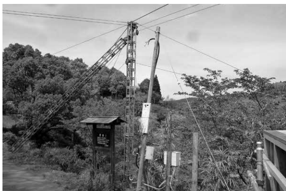
写真19. 索道施設（取入口側支柱）
