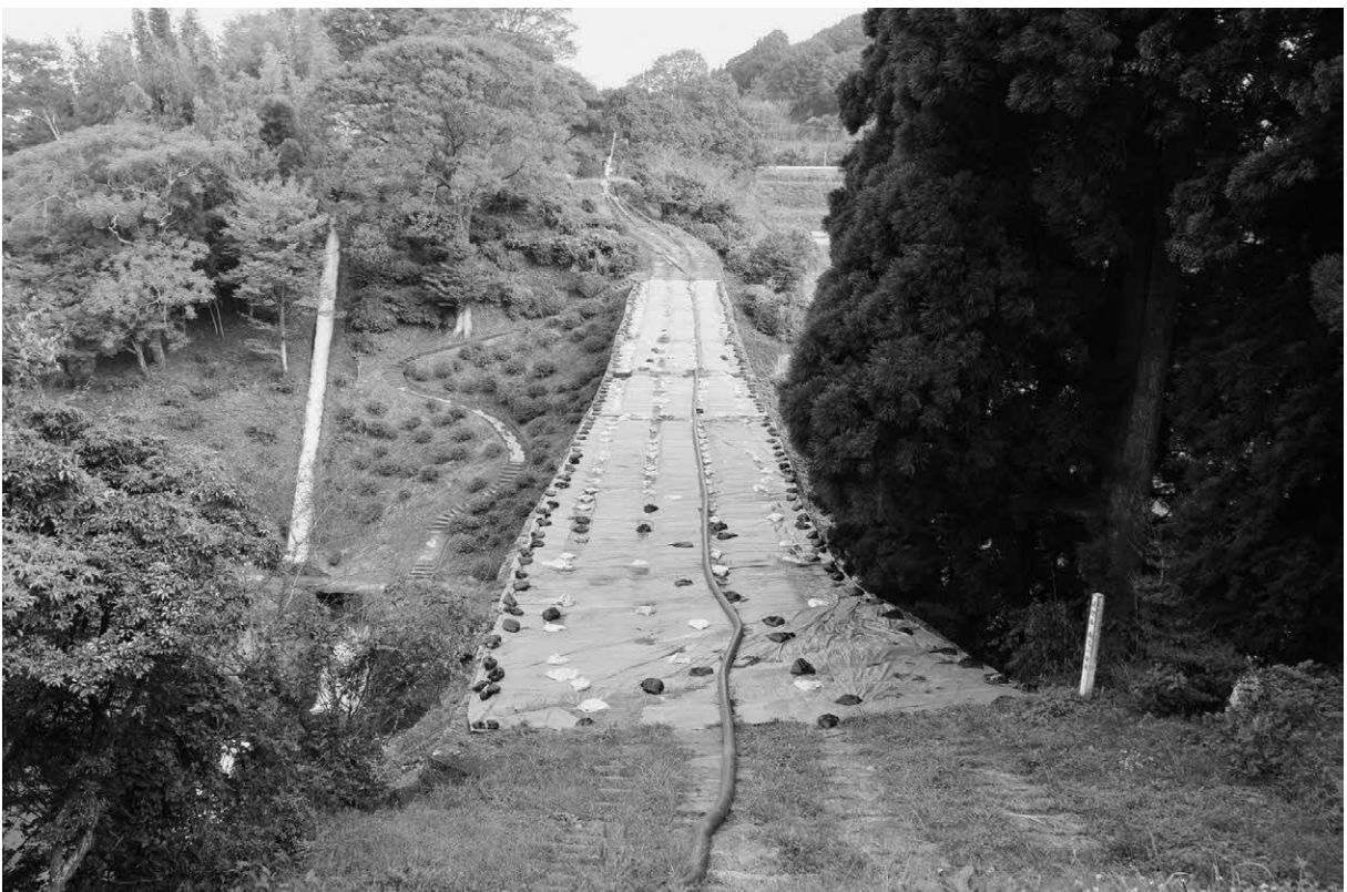
写真18. 修理前橋上面全景（平成28年11月）
