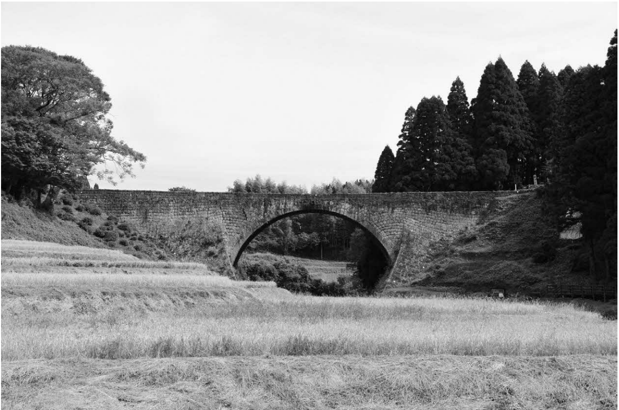
写真17. 修理前上流側全景（平成28年11月）
