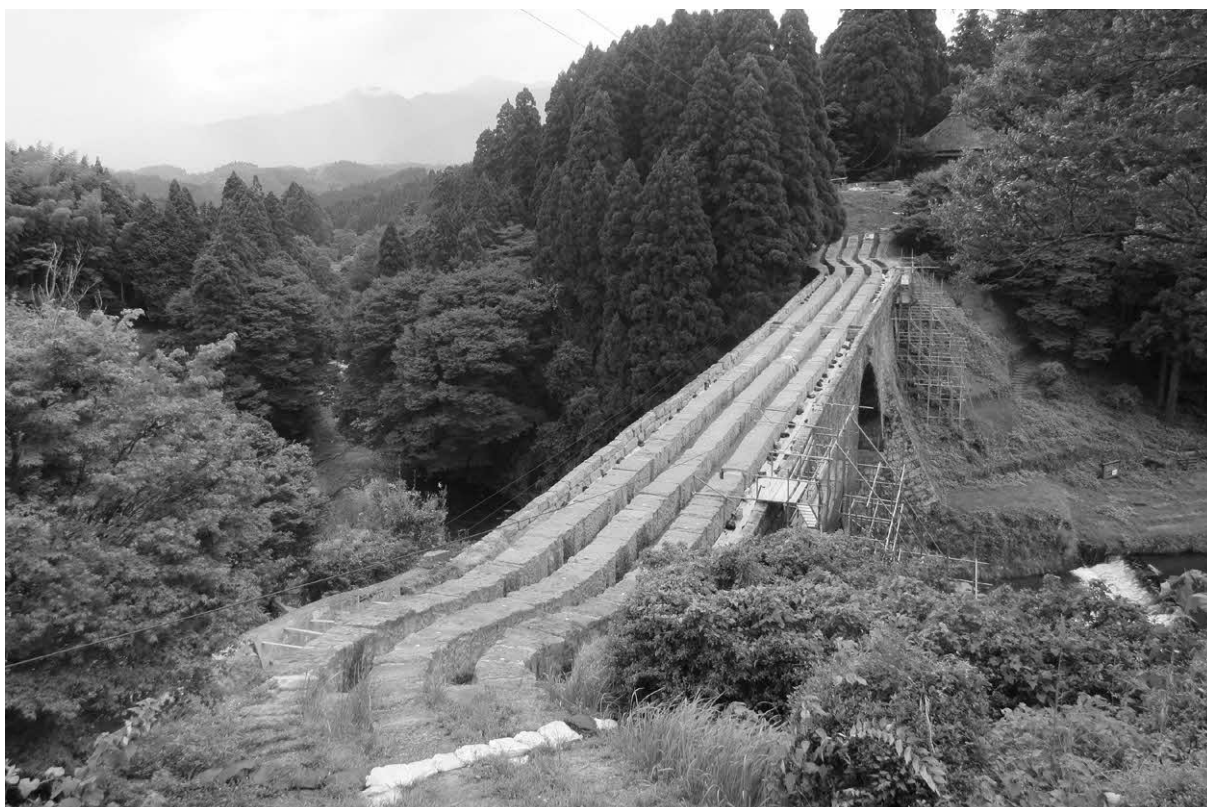
写真23. 掘削後橋上面全景
