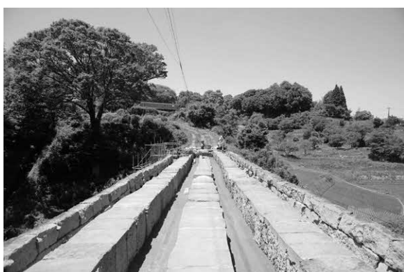
写真21. 被覆土掘削
