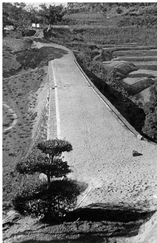
写真13. 昭和46年修理後の橋上 (通水管上部、盛土により被覆)
