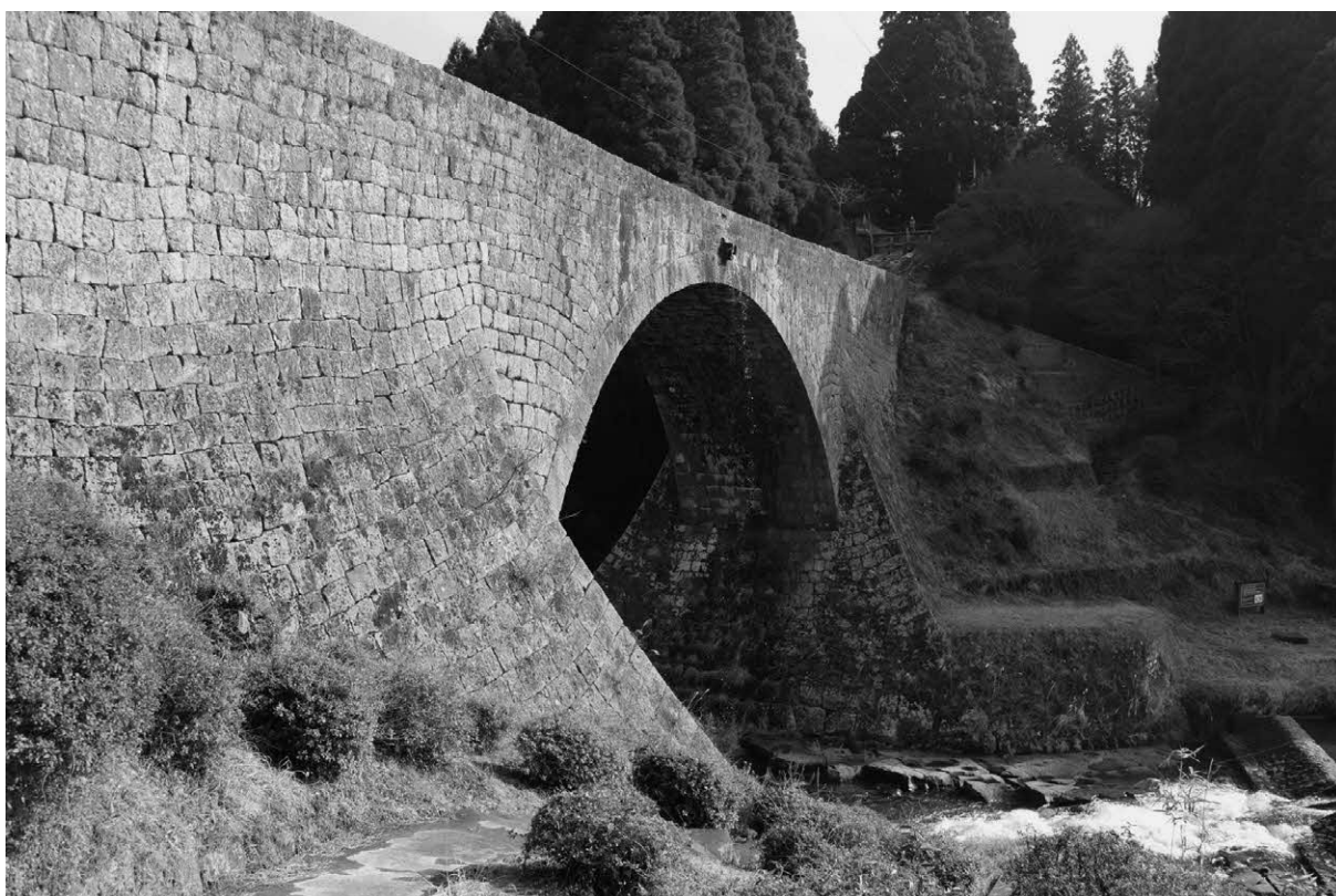
写真40. 修理後上流側全景（平成30年3月）
