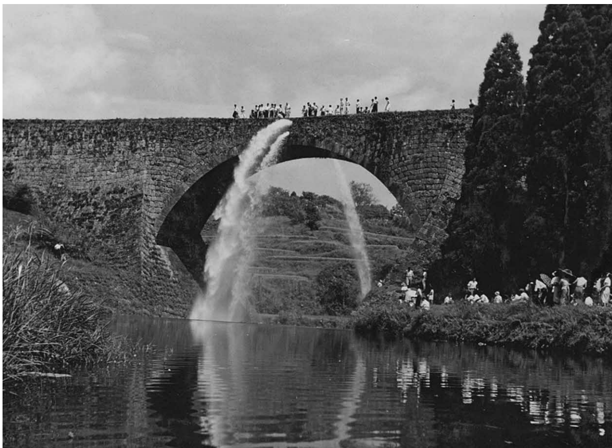
写真6. 昭和35年（1960）頃の放水 ※写真原題「水路土砂掃除吐水状況」
