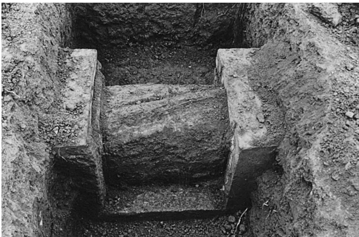
写真14. 通水管の木管部 (昭和46年に取替えられた松材)
