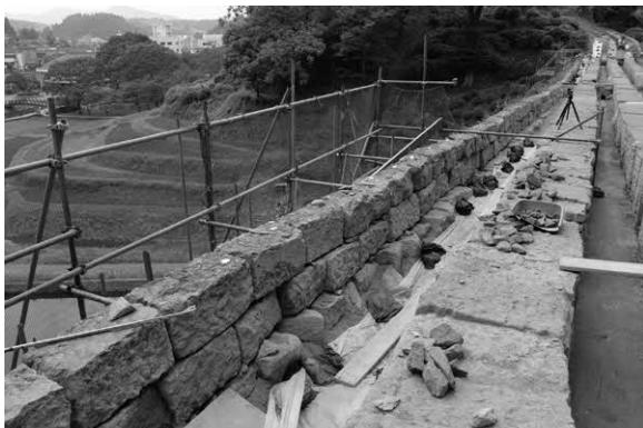
写真28. 上流右岸側手摺石据え直し完了
