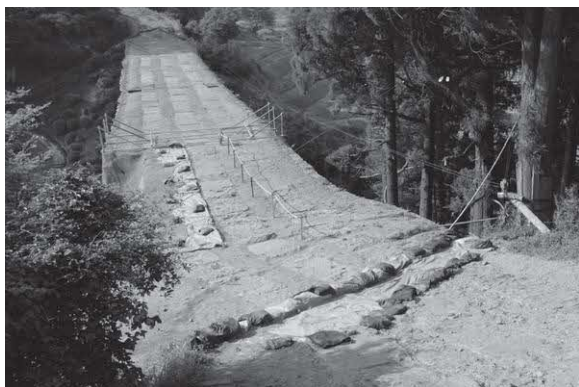
写真48. 壁石支保工及び土囊による応急処置
