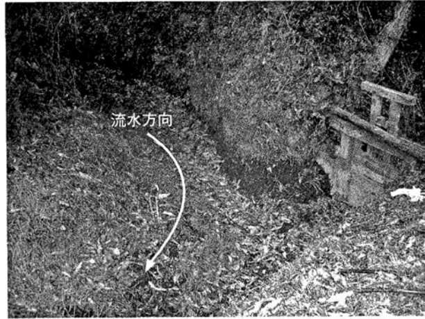
写真(PL)36 下井手22号水路 余水吐(水落シ砂蓋)一帯
