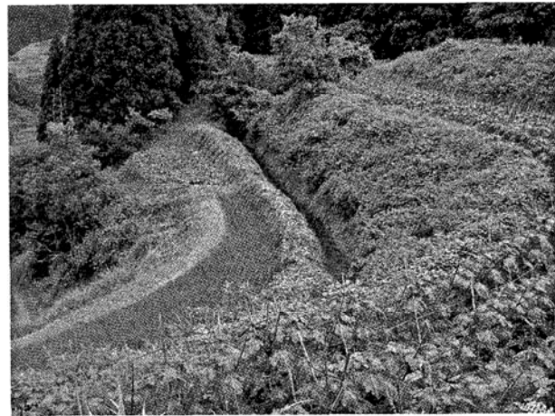
写真(PL)34 下井手21号水路 開水路全景
