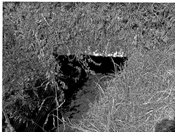
写真(PL)13 下井手6号水路 上流坑口
