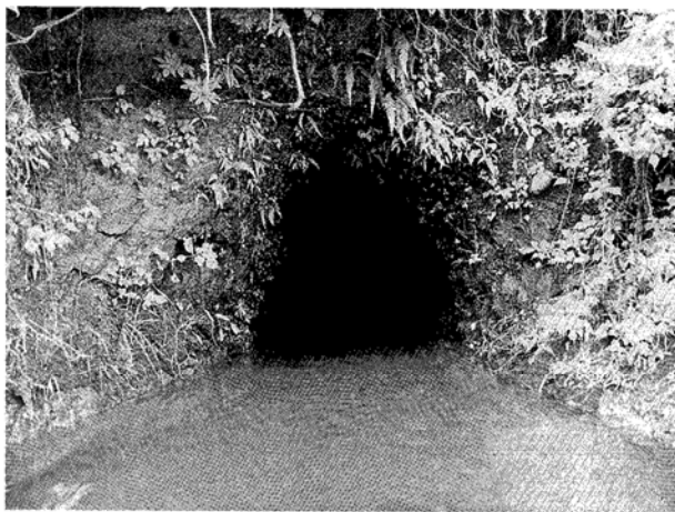
写真(PL)22 上井手11号水路 下流坑口
