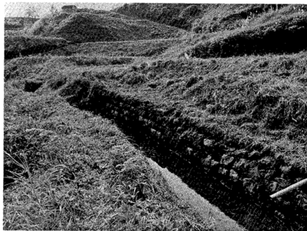
写真(PL)12 下井手4号水路 護岸壁
