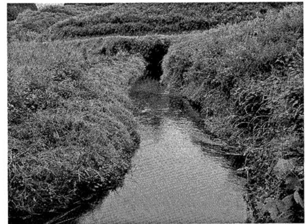
写真(PL)21 下井手11号水路 開水路
