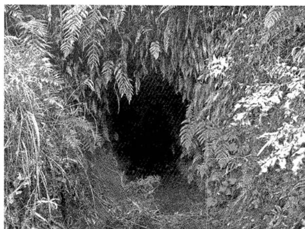
写真(PL)27 下井手13号水路 下流坑口
