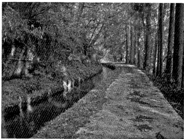
写真(PL)6 上井手2号水路 泥ぜん抜き区間
