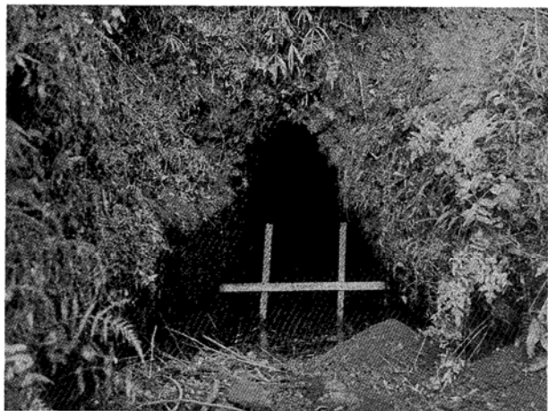
写真(PL)9 下井手3号水路 上流坑口
