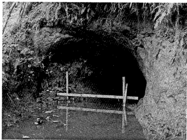
写真(PL)8 下井手2号水路 下流坑口
