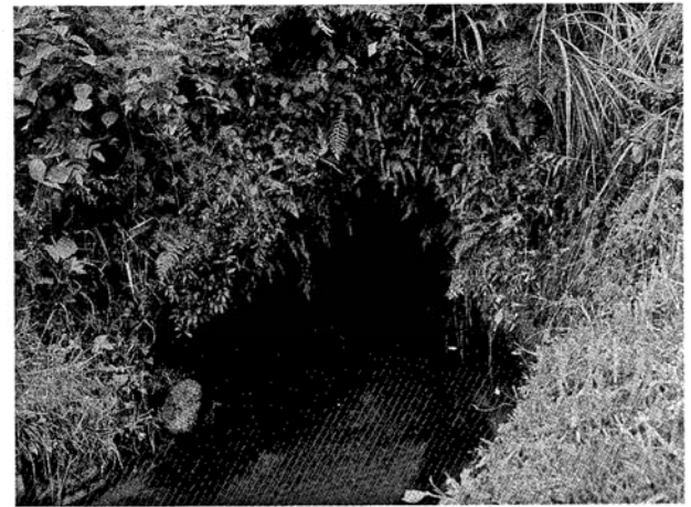
写真(PL)20 下井手11号水路 上流坑口
