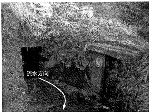
写真(PL)30 下井手16号水路 余水吐(水落シ砂蓋)一帯
