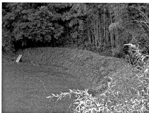
写真(PL)28 下井手14号水路 開水路全景
