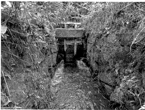
写真(PL)25 下井手12号水路 余水吐と余水路
