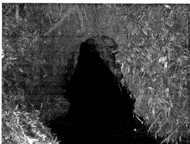
写真(PL)29 下井手14号水路 下流坑口
