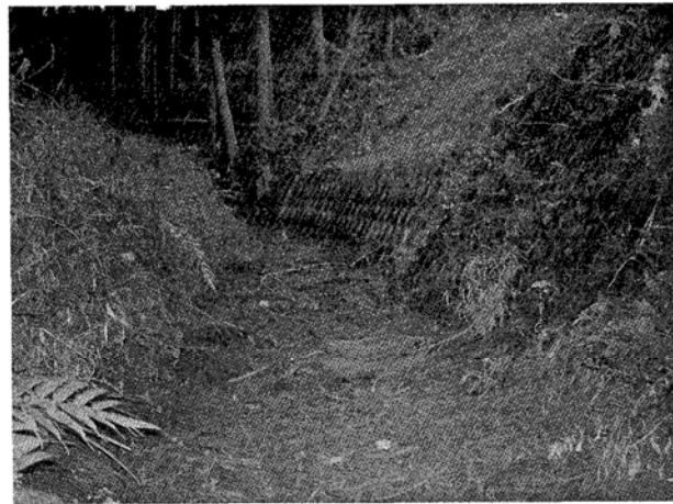
写真(PL)35 下井手22号水路 開水路
