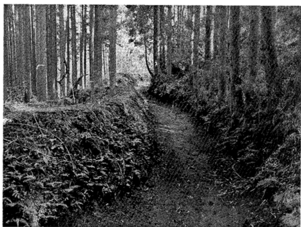
写真(PL)7 下井手2号水路 開水路
