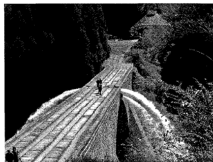
図(Fig)38 通潤橋の放水の様子
