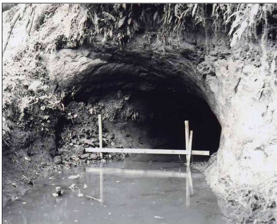
写真(PL)11 通潤用水下井手 2 号水路一下流坑口
