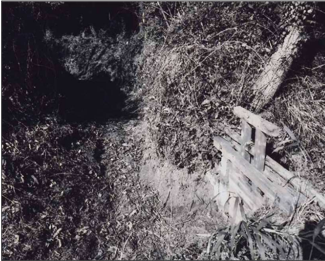
写真(PL) 16 通潤用水下井手 22 号水路（朝寝開き余水吐付近）
