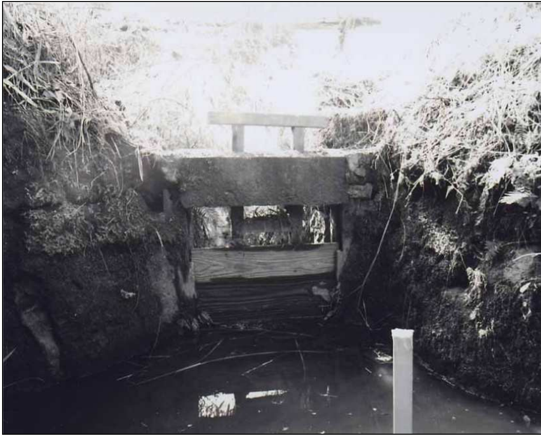
写真 (PL) 14 通潤用水下井手 12 号水路一小ヶ蔵余水吐
