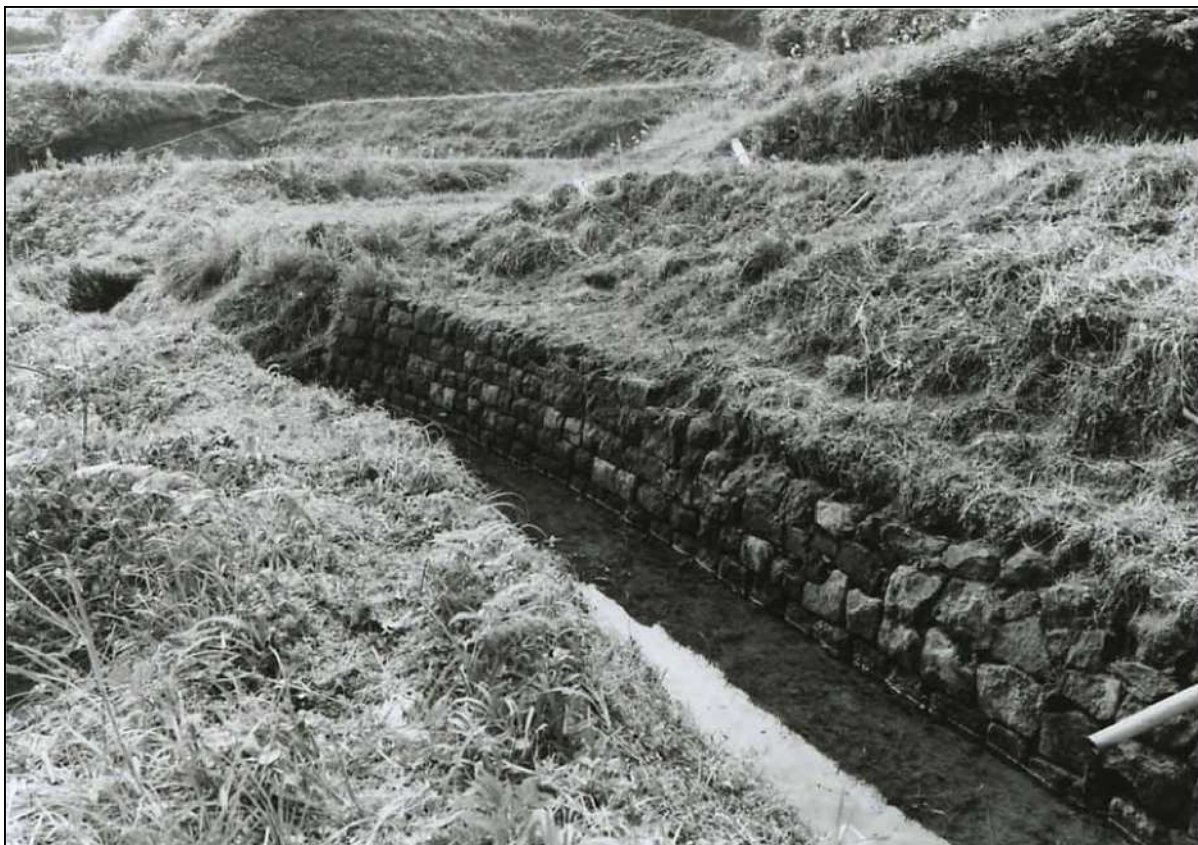
写真 (PL) 12 通潤用水下井手 4 号水路一護岸壁
