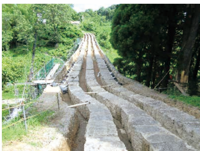
通潤橋の吹上樋
