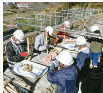
通潤橋 通水管の漆喰詰め替え
