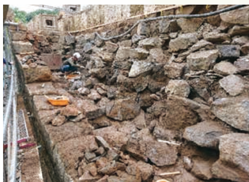
通潤橋の中詰め：裏築の構造
