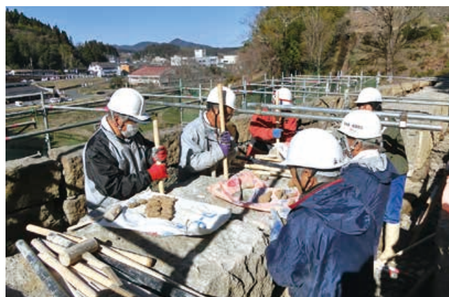
通潤地区土地改良区による通潤橋通水管の漆喰詰め替え (通潤橋保存修理工事中)
