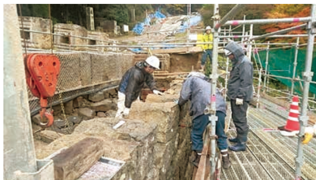
通潤橋保存修理工事 (平成 30 年大雨災害復旧) の様子
