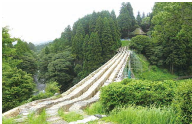
通潤橋保存修理工事 (平成 28 年熊本地震災害復旧) 中の様子
