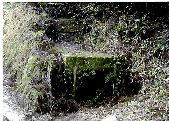
実験跡に残っている石樋
