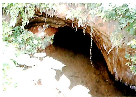
導水坑(トンネル)
