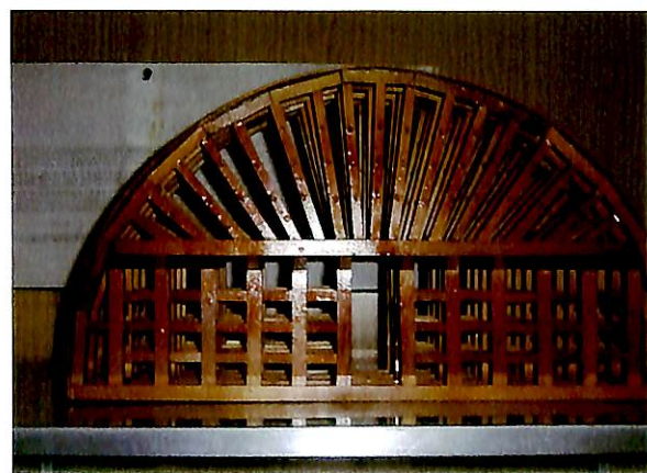
支保工(資料館より)
