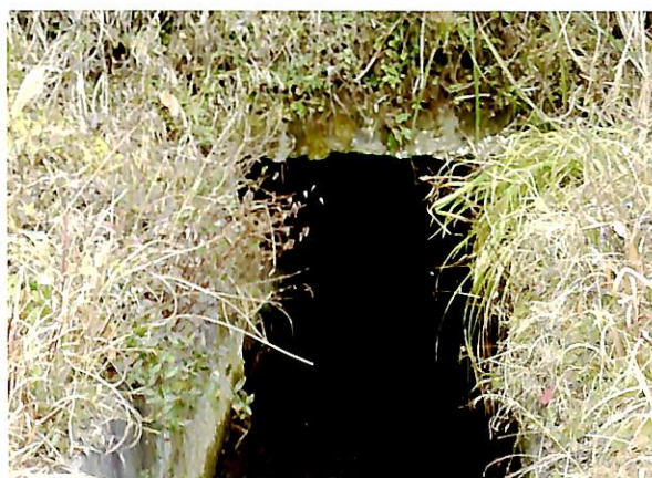
下井手水路取入口
