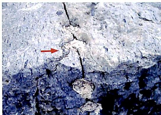
亀裂が大きくなり、上部が剥離する可能性のある石管
