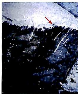
⑥ 石管の亀裂からしみだしている状態
