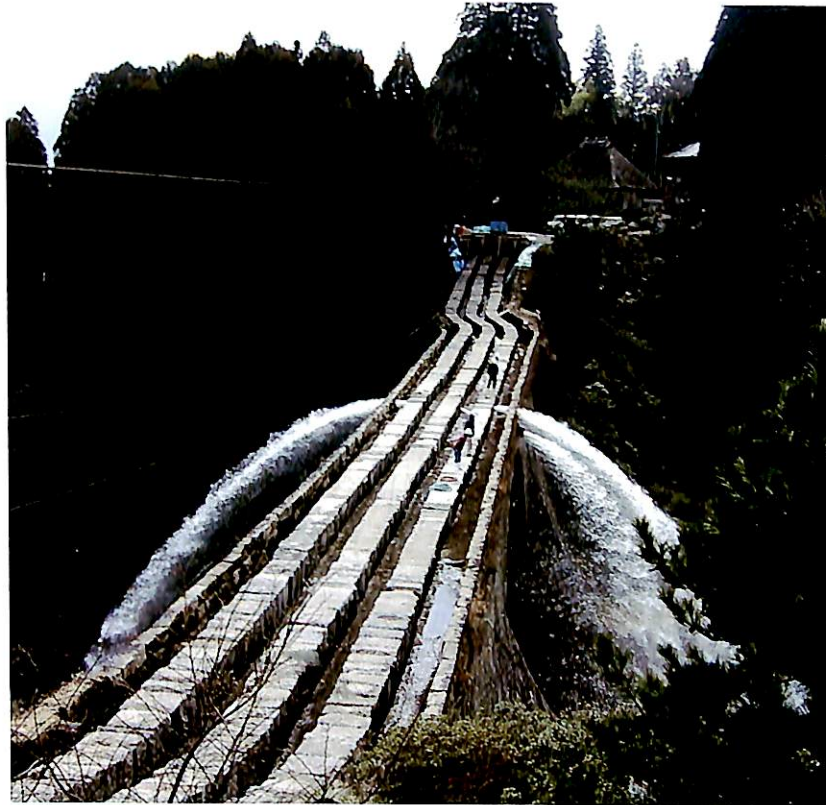
2002年(平成14年)改修時 3本の通水管が見える
