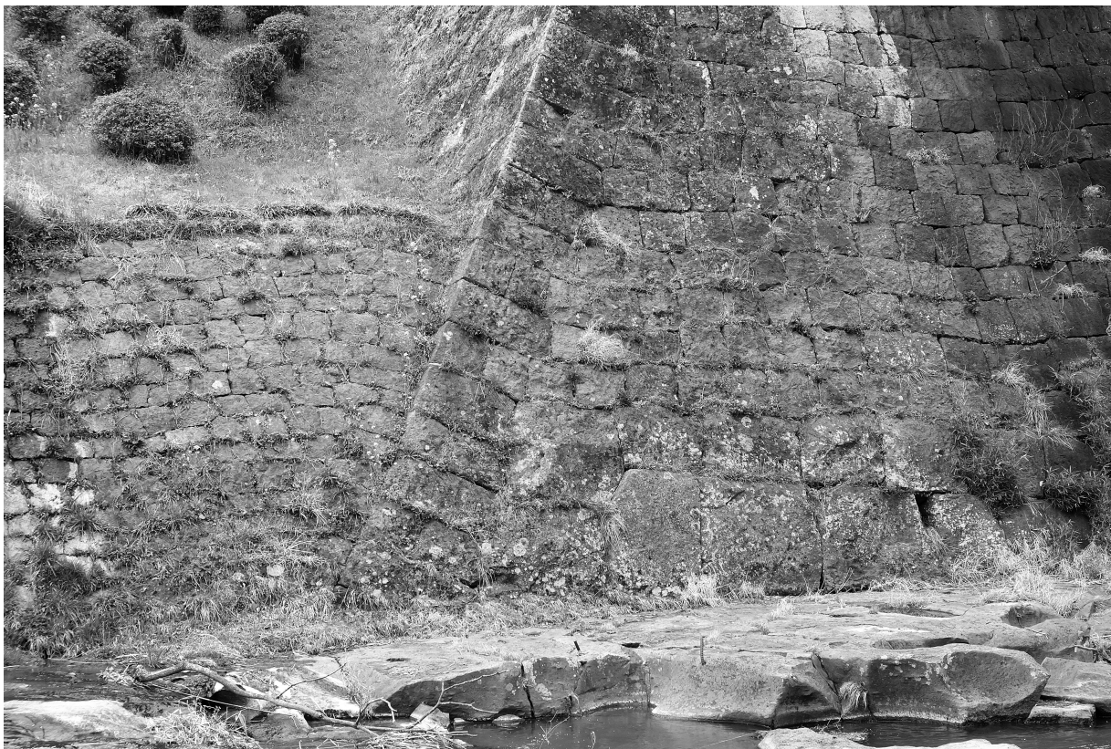
写真23 通潤橋 左岸上流側 鞘石垣隅角部
