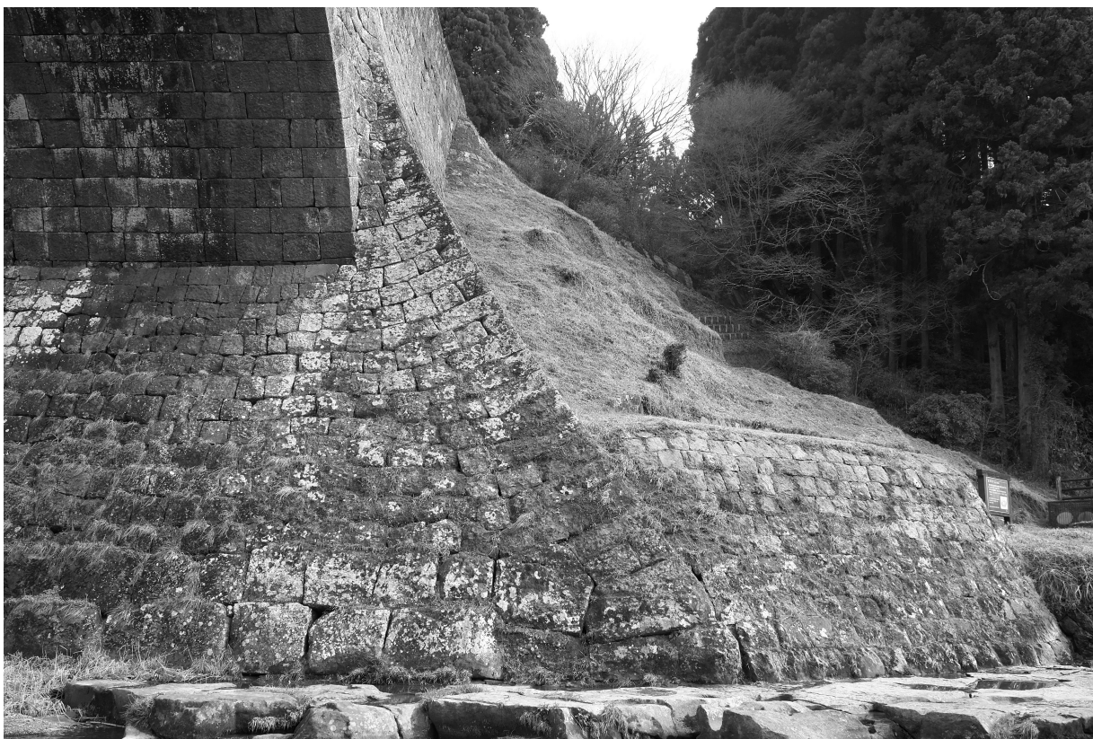
写真24 通潤橋 右岸上流側 鞘石垣隅角部
