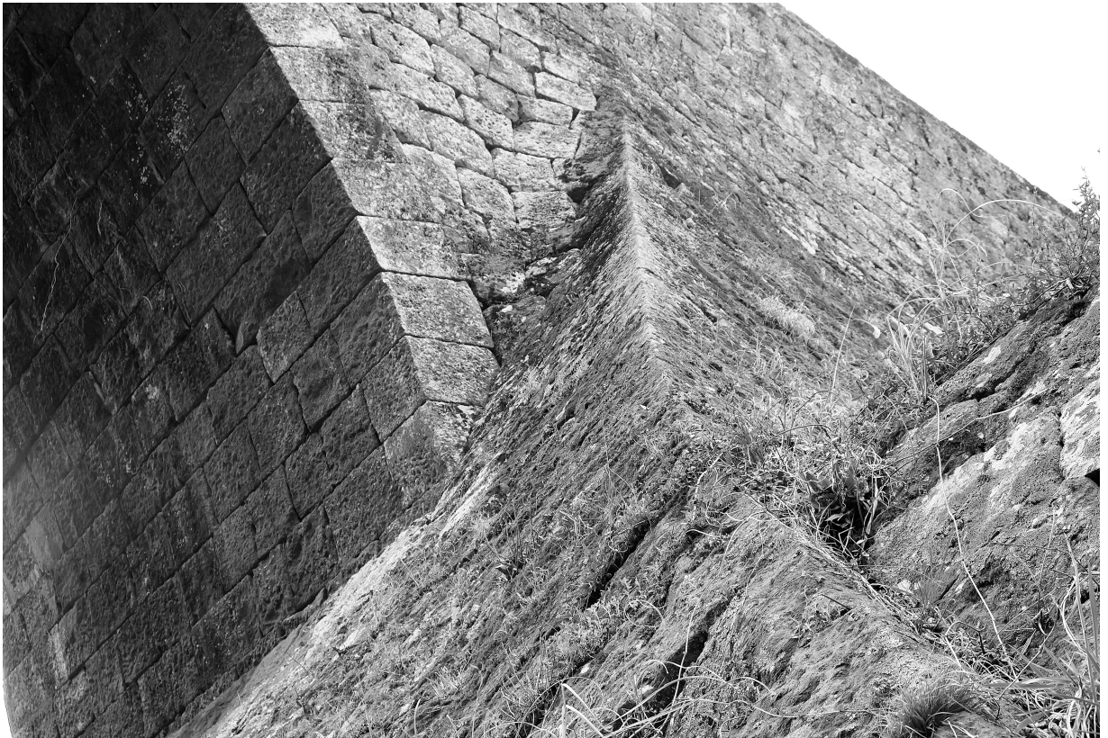
写真22 通潤橋 左岸下流側 鞘石垣と壁石（スパンドレル）の取付状況 近景
