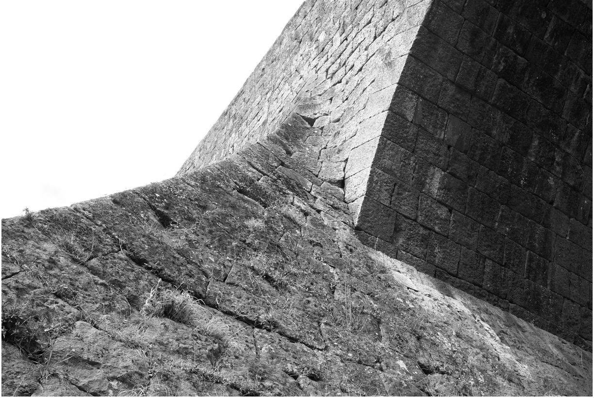
写真21 通潤橋 左岸上流側 鞘石垣と壁石（スパンドレル）の取付状況 近景
