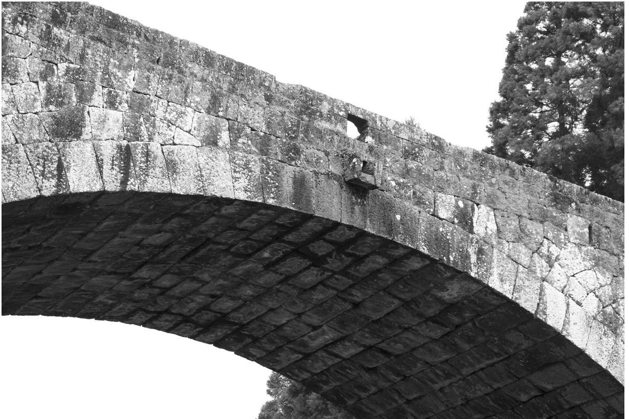
写真10 通潤橋 上流側放水口 近景
