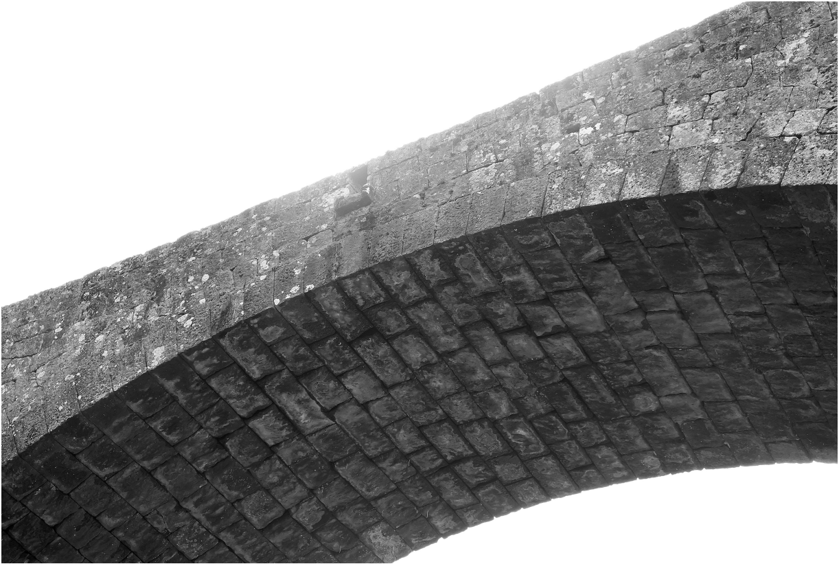
写真11 通潤橋 下流側放水口 近景
