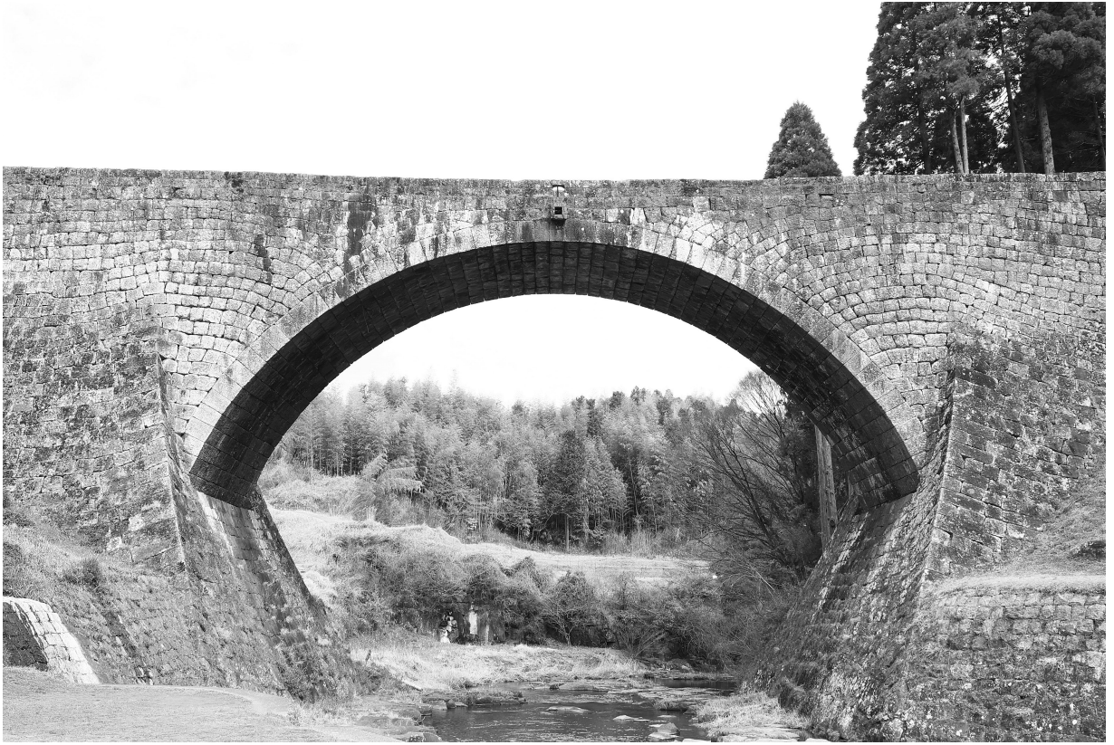
写真9 通潤橋 輪石・鞘石垣・放水口 全景（上流側）
