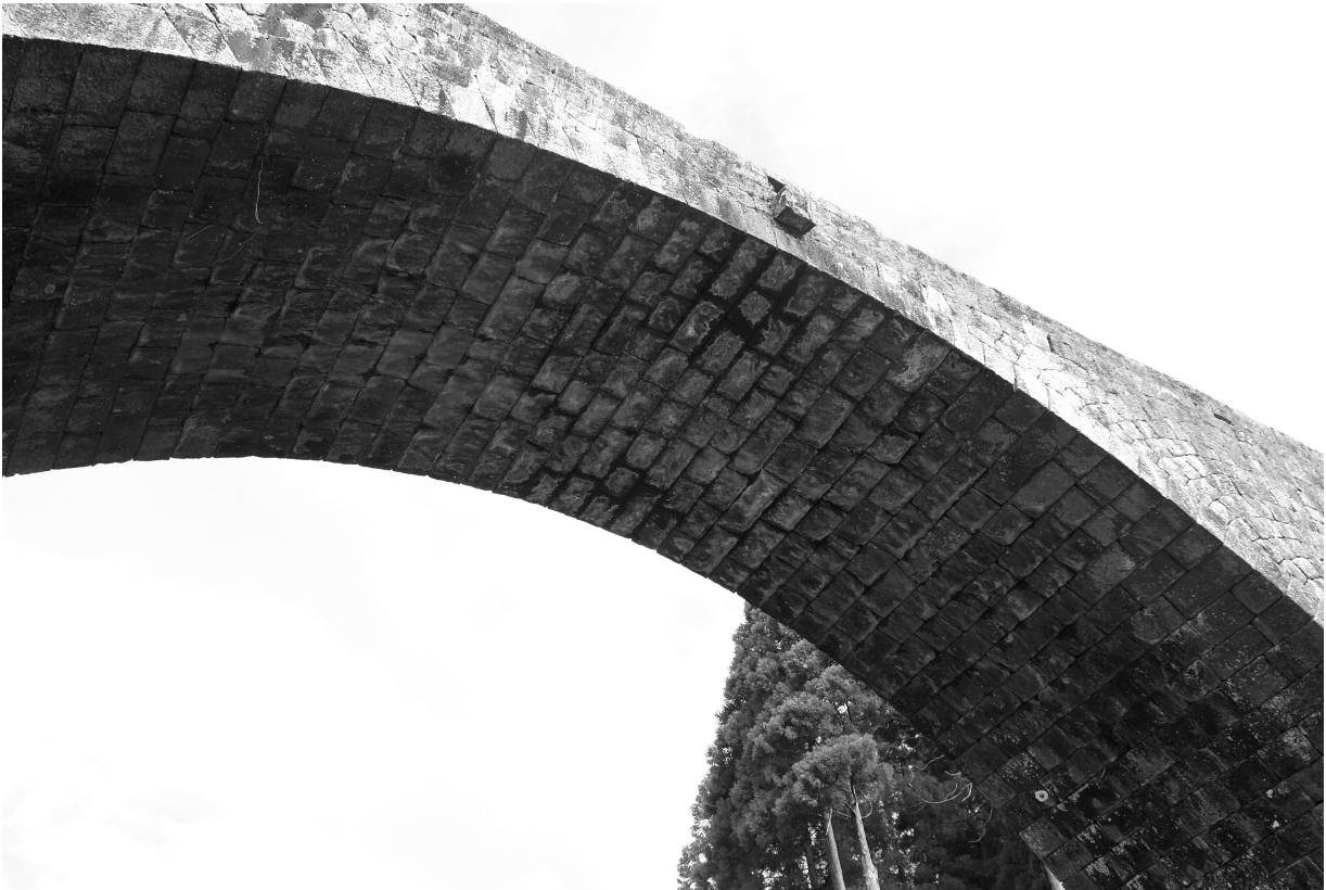
写真12 通潤橋 輪石中央部（上流側より）
