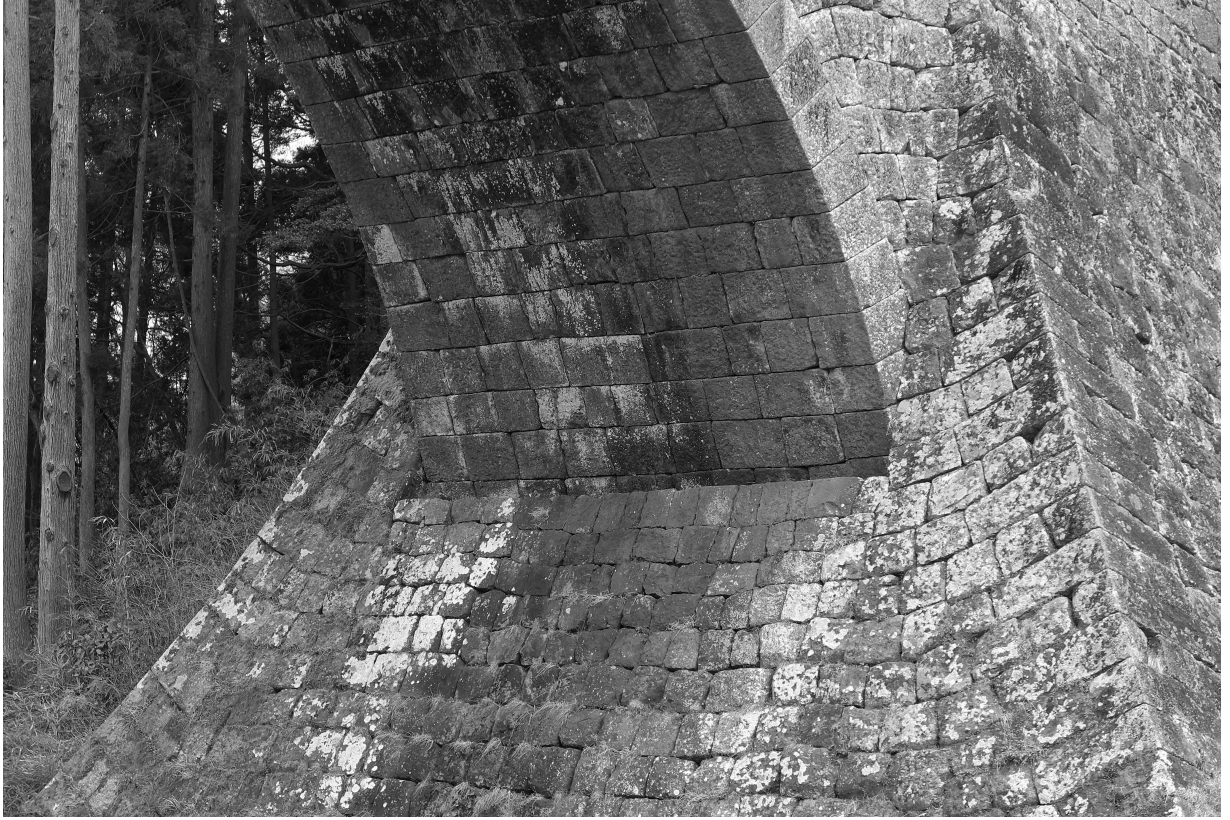
写真17 通潤橋 右岸側 輪石と鞘石垣の取付状況
