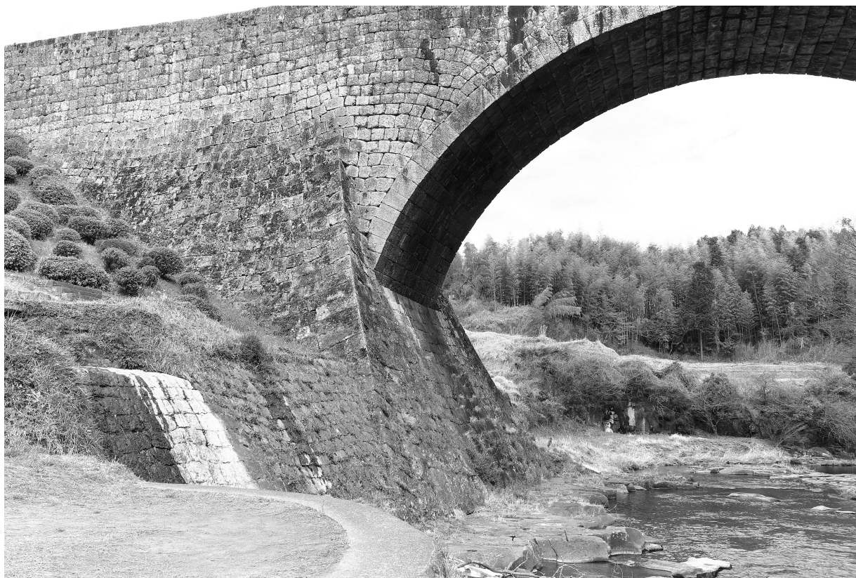
写真19 通潤橋 左岸上流側 鞞石垣と側壁の取付状況
