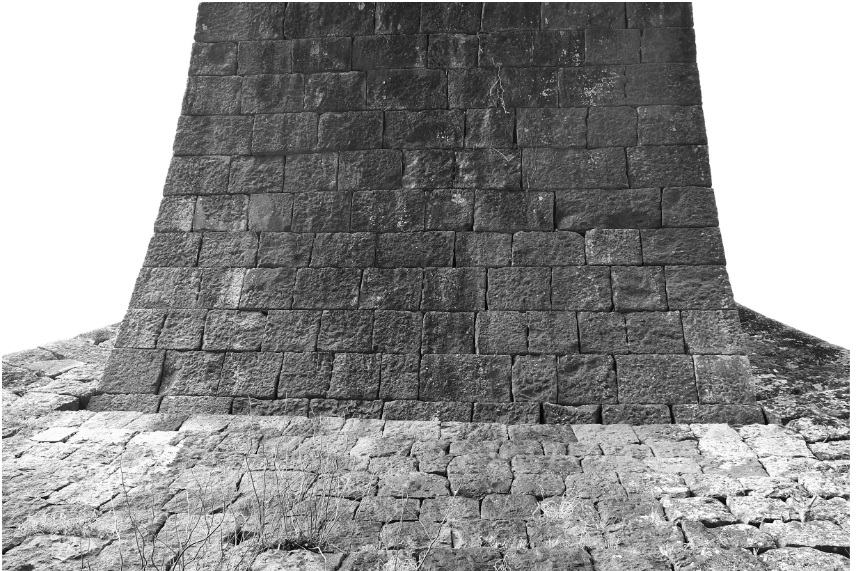
写真18 通潤橋 左岸側 輪石と鞘石垣の取付状況 近景
