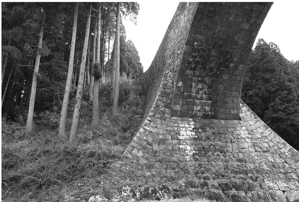
写真20 通潤橋 右岸下流側 鞞石垣と側壁の取付状況
