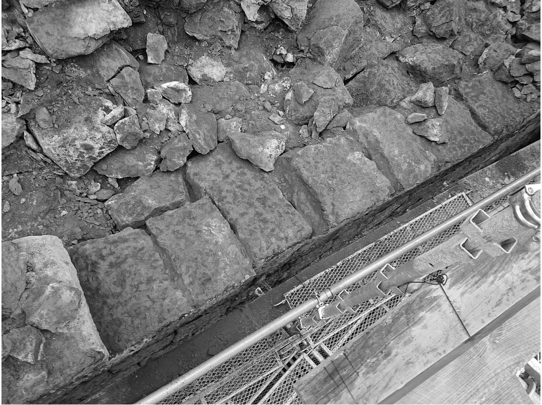
写真45 通潤橋 壁石にみられる長尺の石材①（令和元年（平成31年度）保存修理工事 / 裏築解体時）
