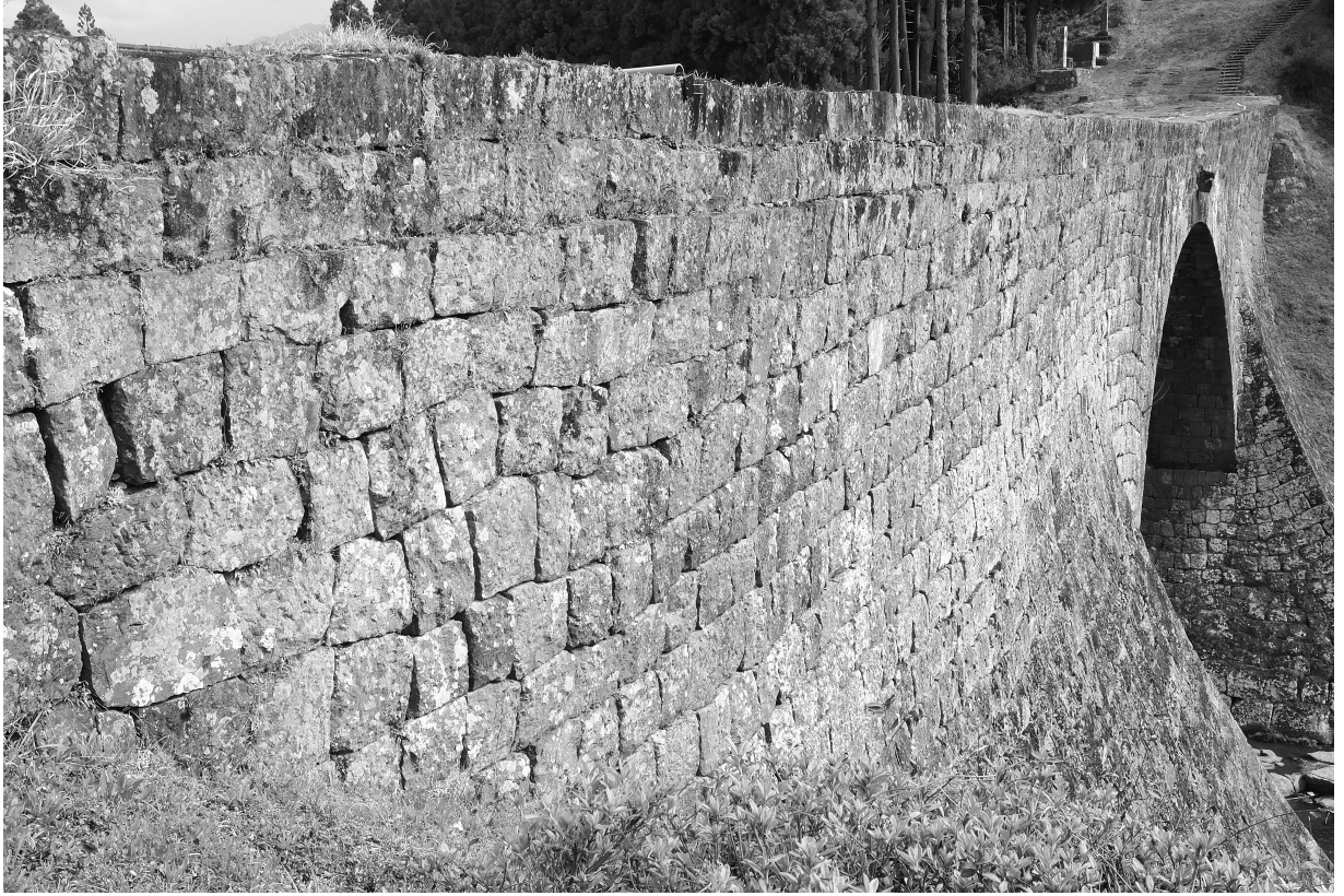
写真29 通潤橋 左岸上流側 側壁
