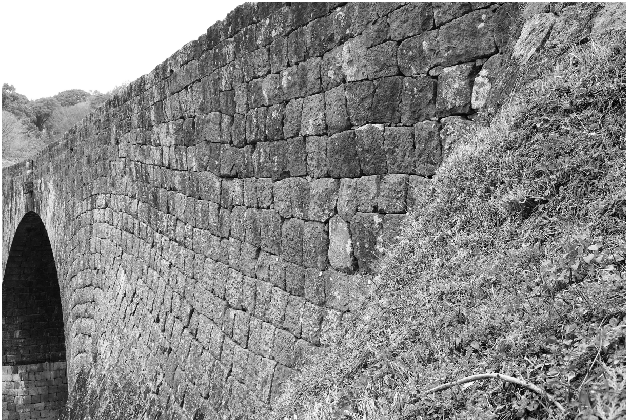
写真30 通潤橋 右岸上流側 側壁
