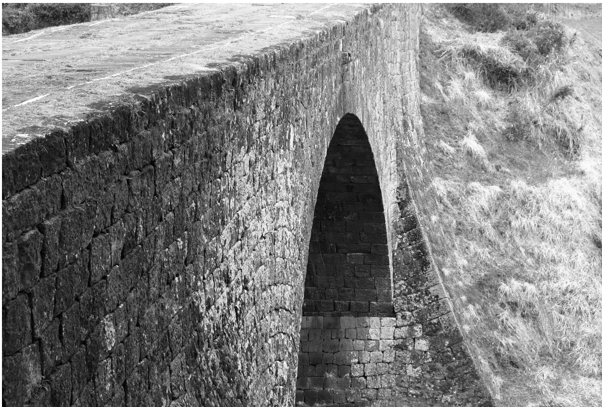
写真31 通潤橋 下流側 側壁 (右岸下流側より)
