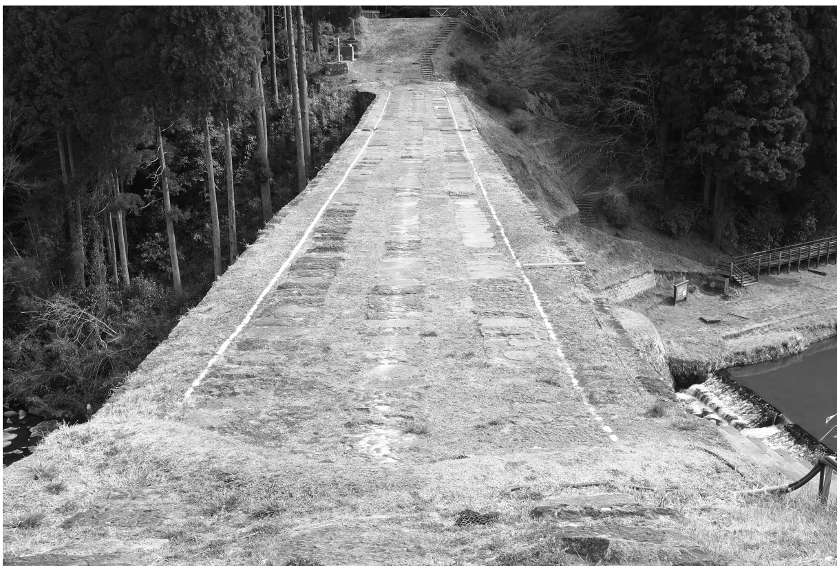
写真32 通潤橋 橋上の現況① (左岸側から右岸側を望む)
