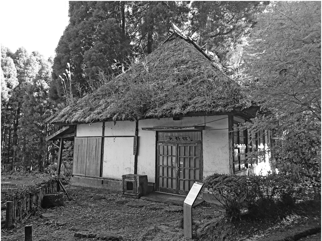
写真62 御小屋（西側より）
