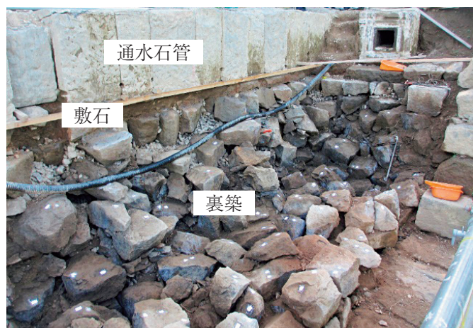
写真5-1-13 通水石管と裏築部の状況
