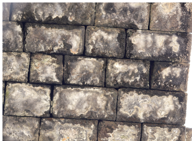
写真5-1-12 通潤橋の輪石を見上げた状況
