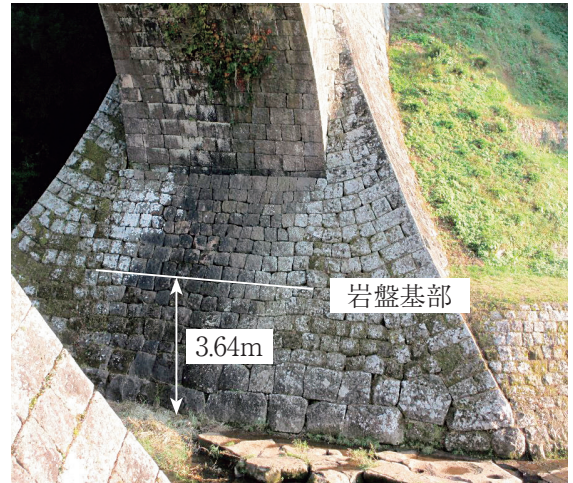
写真5-1-11 現況の通潤橋のアーチ基部
