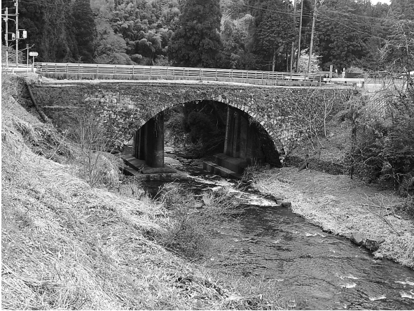
図4-1-2 聖橋（男成川目鑑橋）
