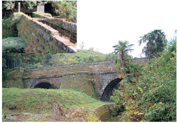
写真5-1-4 第三区明治大分水路橋
