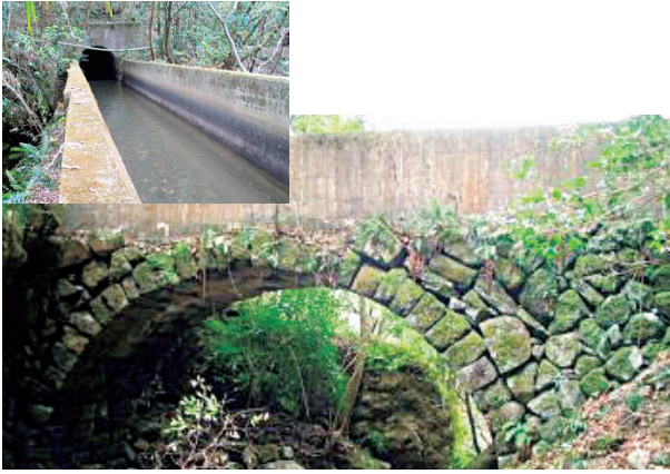
写真5-1-3 藤ヶ谷水路橋
