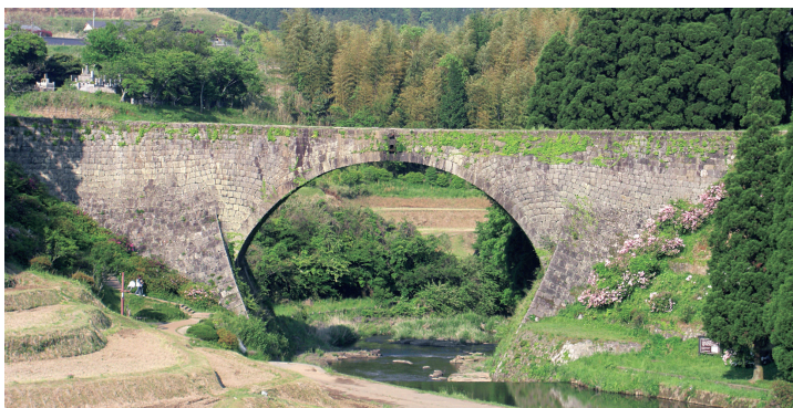
(a) 正面からみた通潤橋の全景
