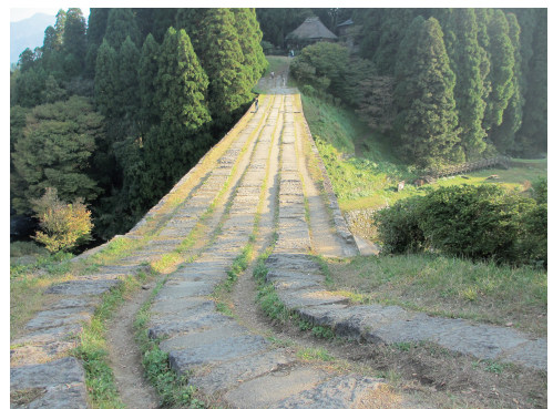
(b) 橋上面の通水石管の様子
