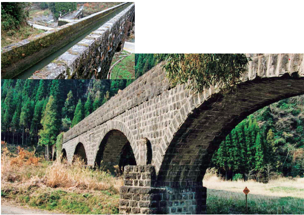
写真5-1-5 明正井路一号幹線一号橋
