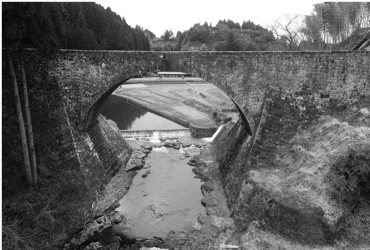
写真7 通潤橋 下流側立面
