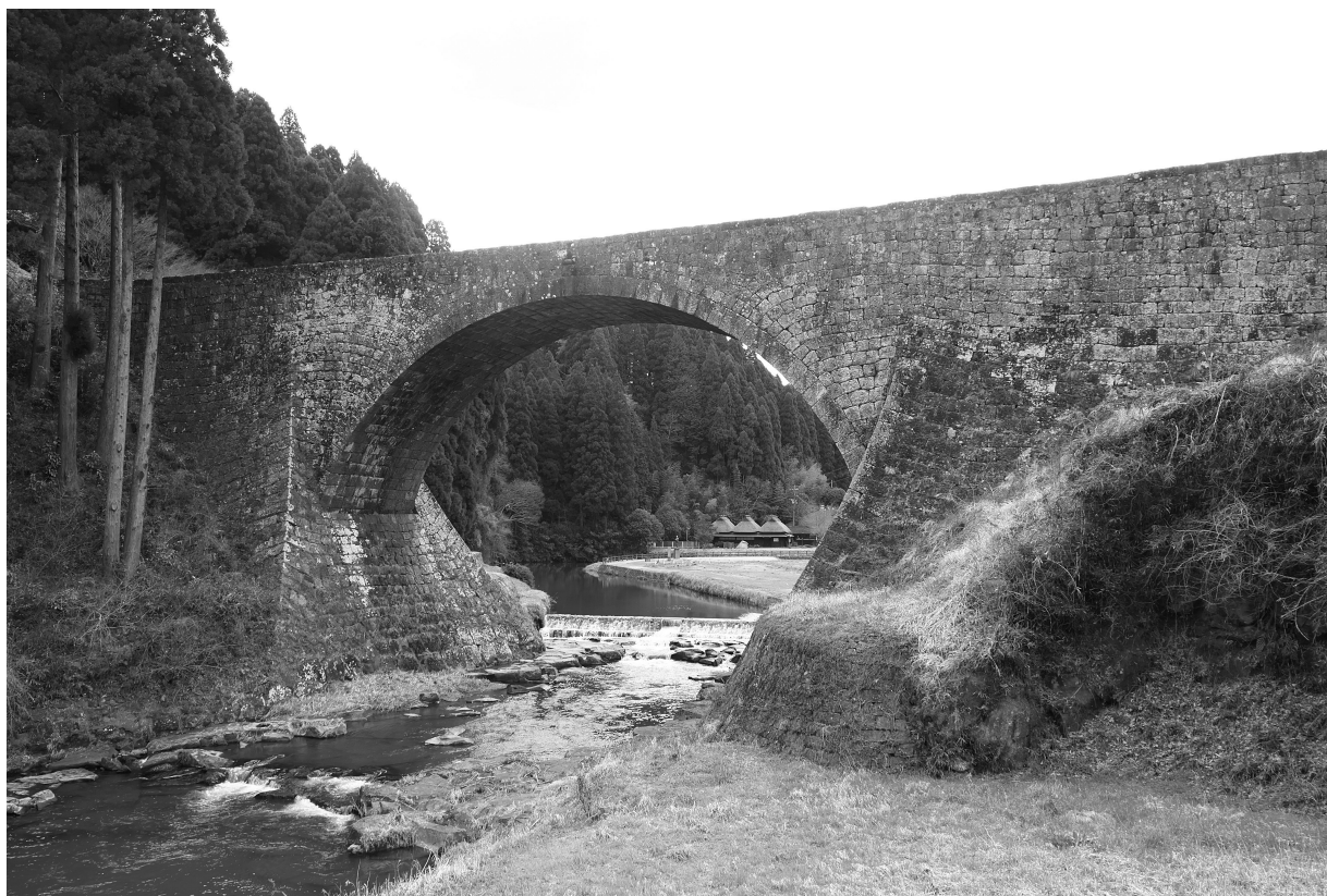
写真8 通潤橋 下流側全景
