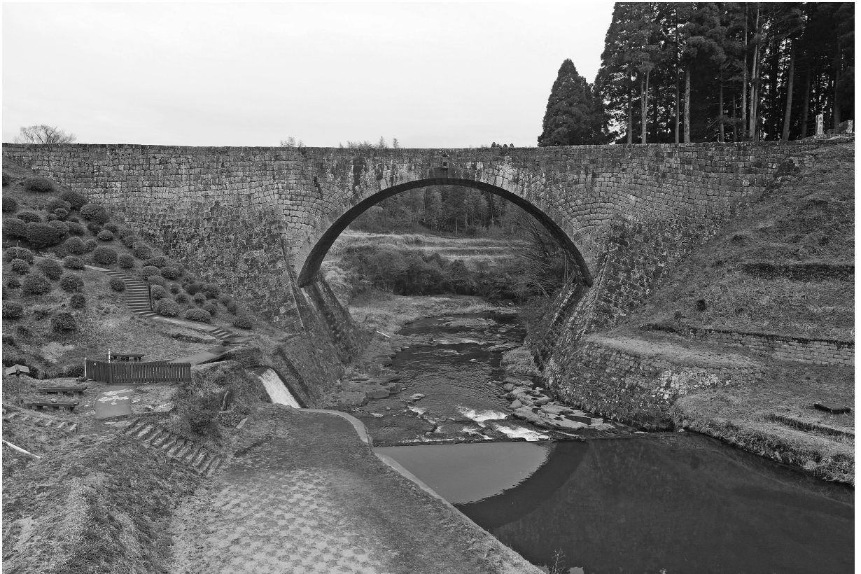
写真6 通潤橋 上流側立面②
