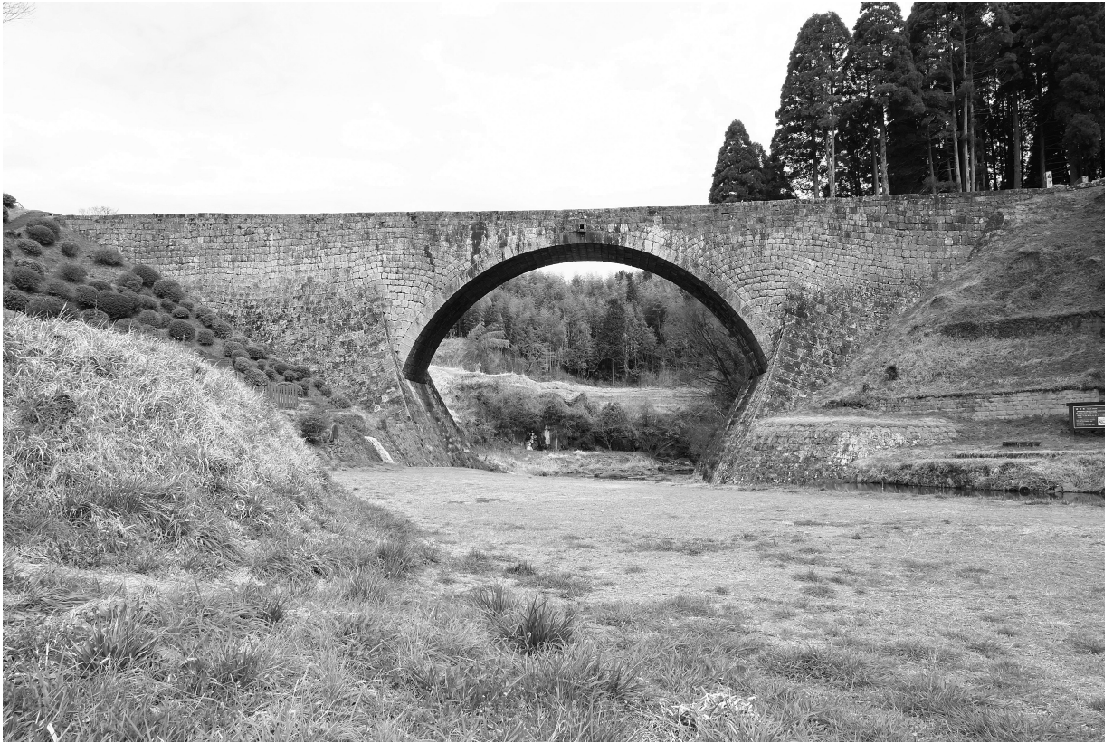
写真5 通潤橋 上流側立面①
