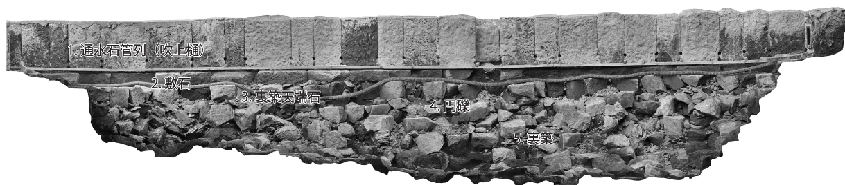
図3-2-2 通潤橋の内部構造（オルソ画像）
