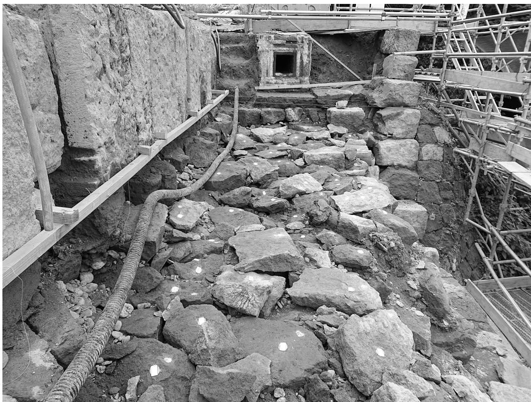
写真40 通潤橋 裏築（最上層）検出状況（令和元年（平成31年度）保存修理工事）
