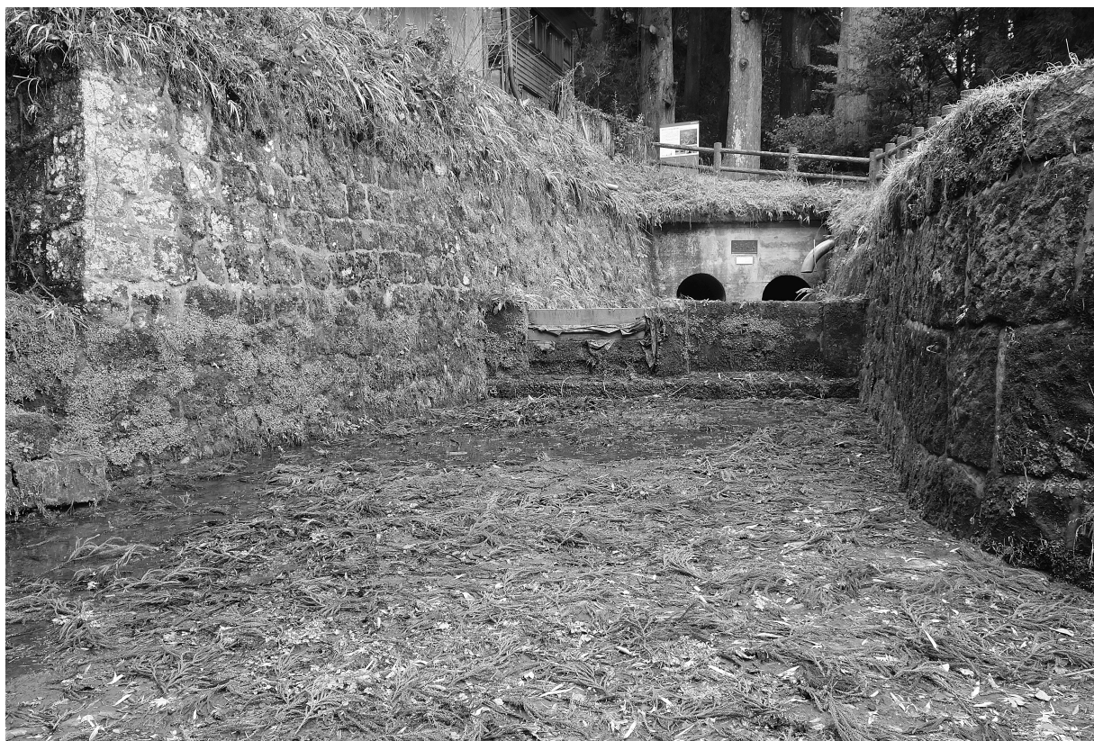
写真56 通潤橋吹上口 近景③ (中央部より下流方向を望む)
