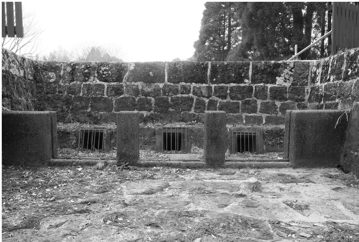
写真55 通潤橋吹上口 近景② (通水石管 (吹上樋) との接続部)
