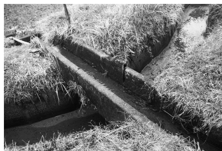
図5-3-31 水路の立体交差部の天水吐
