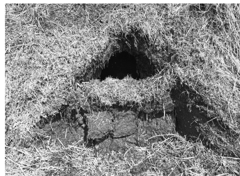
図5-3-25 水路トンネル中央部の排砂用の穴
