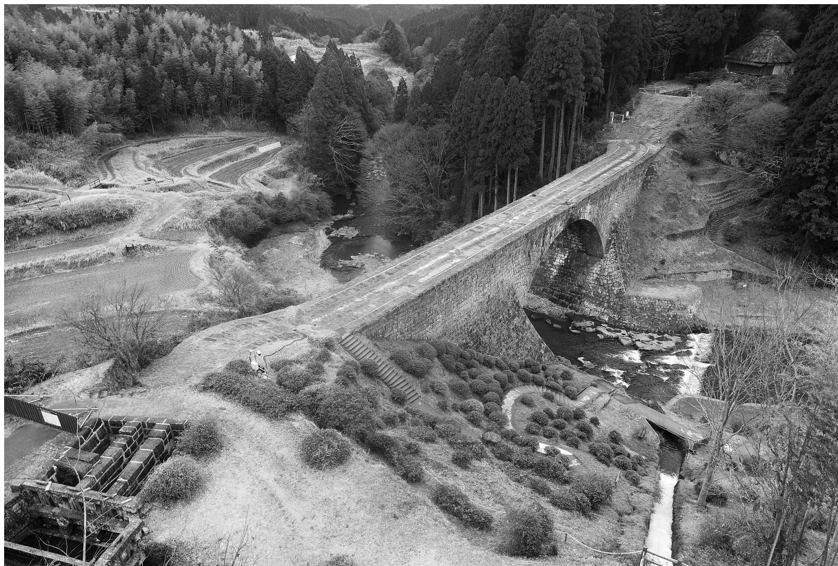
写真3 通潤橋 全景② (左岸上流側より五老ヶ滝方向を望む。左下は取入口)
