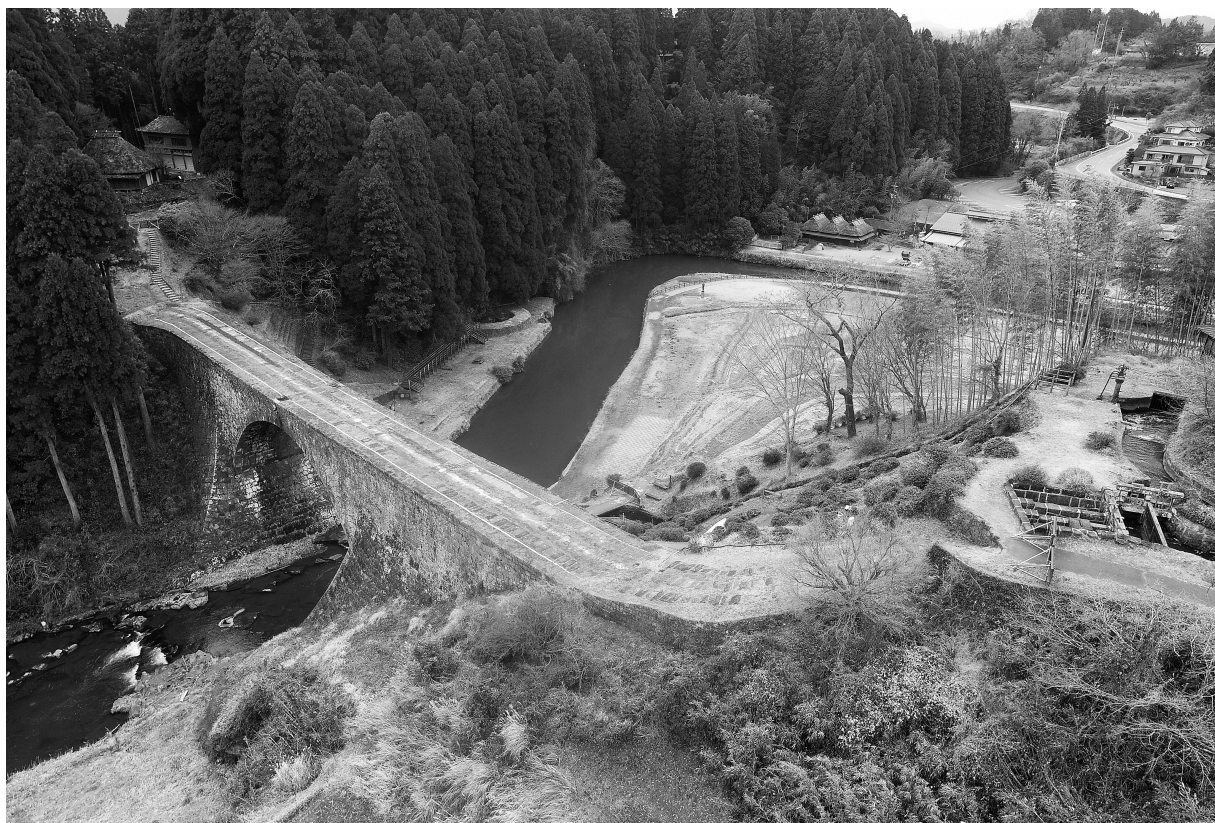
写真4 通潤橋 全景③ (左岸下流側より五老滝川上流方向を望む。右下は取入口)
