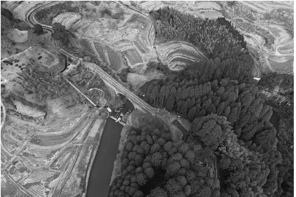
写真2 通潤橋 全景① (左上取入口 / 右下吹上口)
