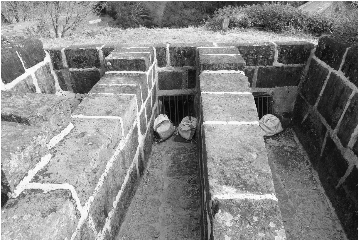
写真50 通潤橋取入口 近景③ (通水石管 (吹上樋) との接続部)
