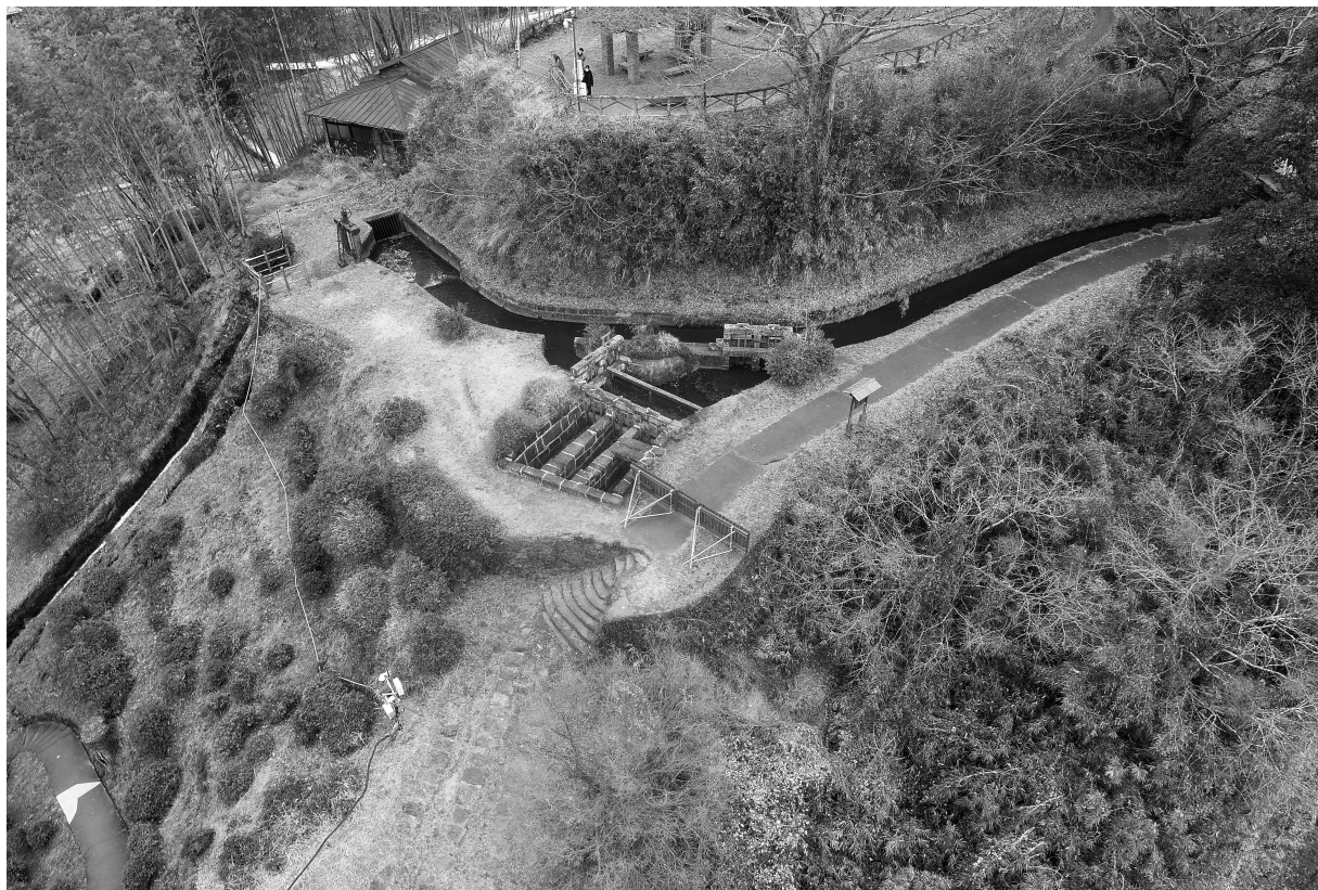
写真47 通潤橋取入口 全景 (左下 通潤橋方向)
