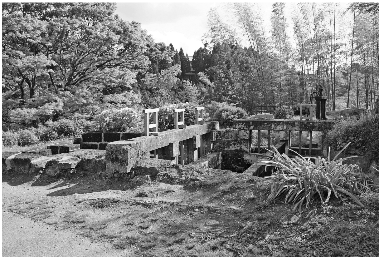
写真48 通潤橋取入口 近景① (左 通潤橋方向 / 右 上井手方向)
