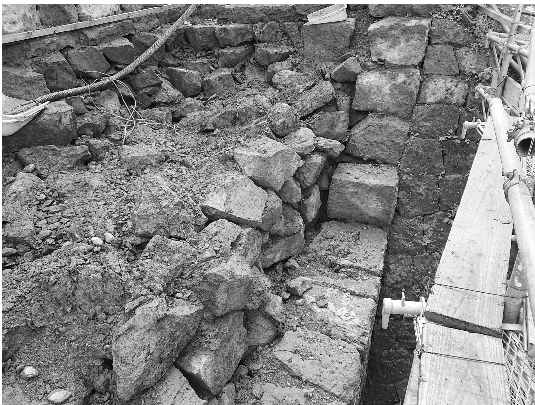
写真44 通潤橋 裏築と壁石（築石）④（令和元年（平成31年度）保存修理工事 / 裏築解体時）
