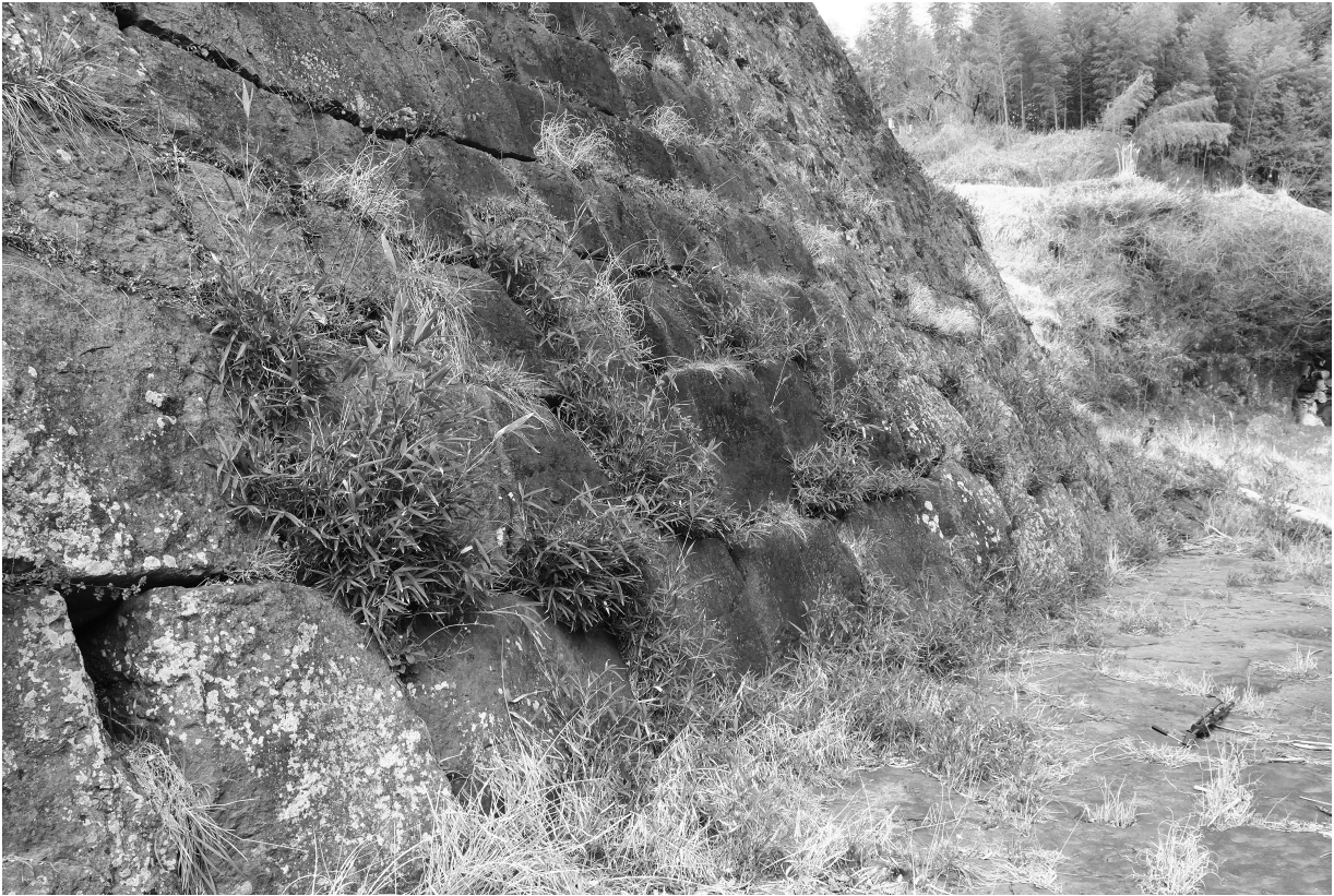
写真27 通潤橋 左岸下流側 鞘石垣基部 近景
