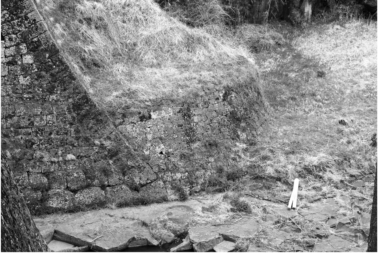
写真25 通潤橋 左岸下流側 鞘石垣隅角部
