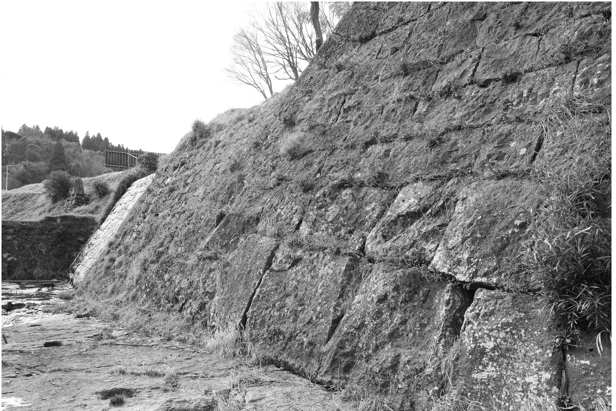
写真26 通潤橋 左岸上流側 鞘石垣基部 近景
