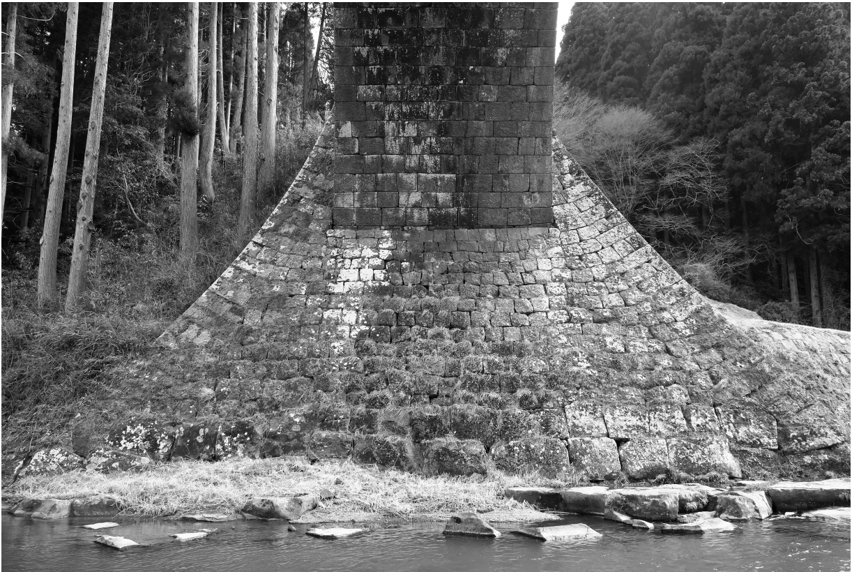
写真28 通潤橋 右岸側 鞘石垣基部の状況
