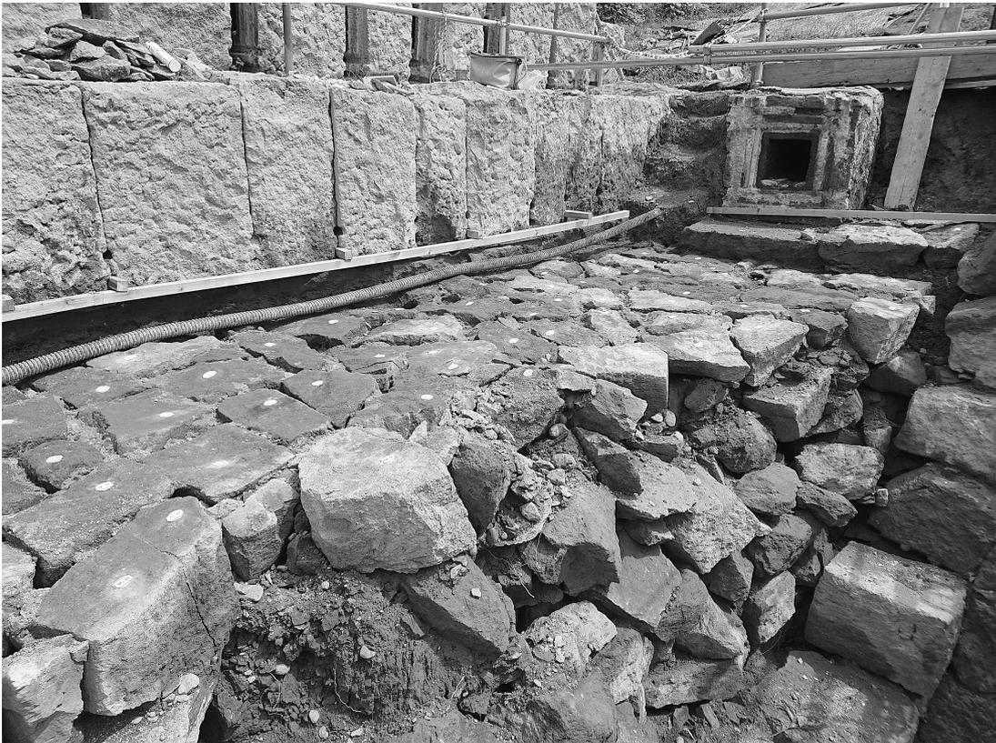
写真38 通潤橋 裏築天端石 検出状況（令和元年（平成31年度）保存修理工事）
