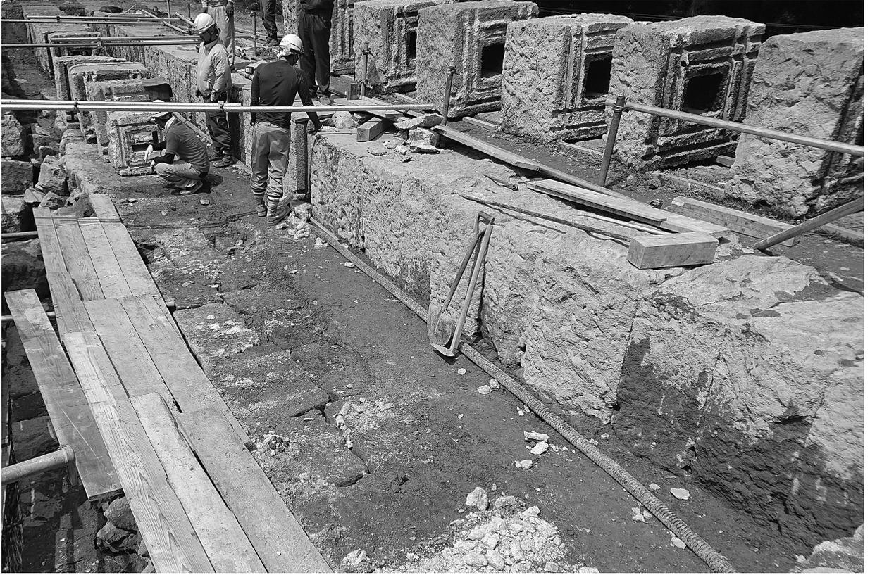
写真37 通潤橋 通水石管直下 敷石検出状況（令和元年（平成31年度）保存修理工事）
