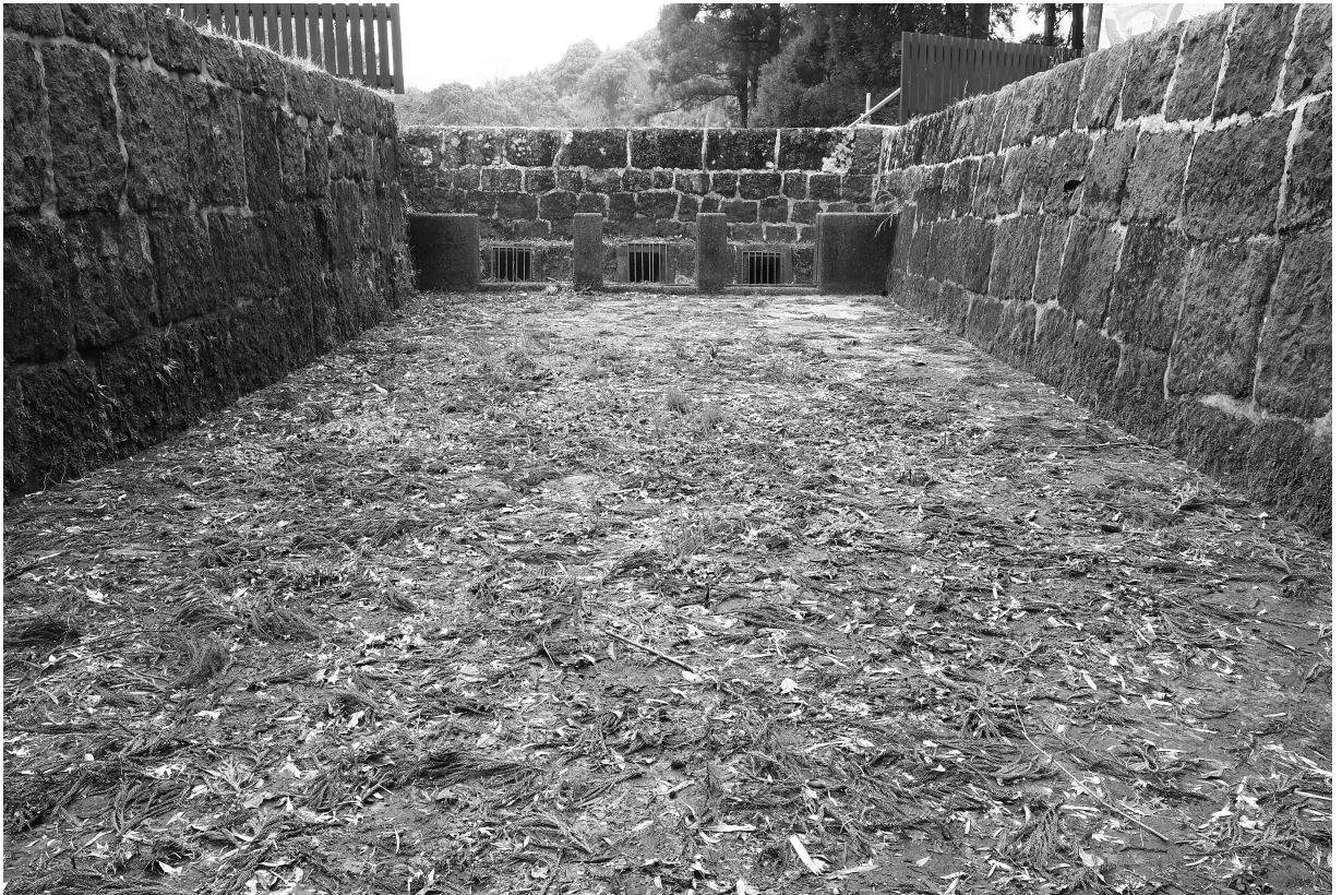
写真54 通潤橋吹上口 近景①（中央部より通潤橋方向を望む）
