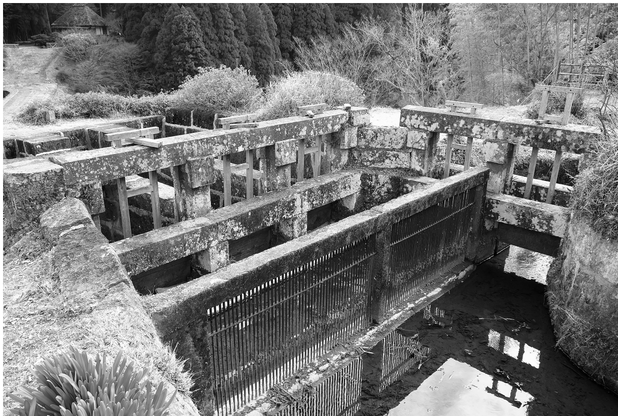
写真51 通潤橋取入口 近景④ (本井手通り砂蓋三基)
