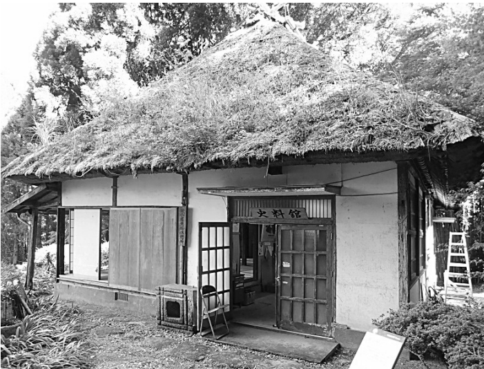
図7-2-13 御小屋 西面(右手は玄関)
