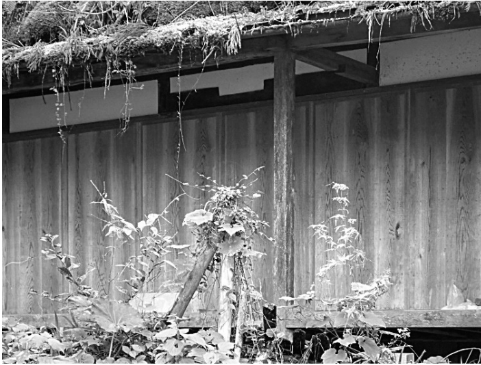
図7-2-21 御小屋(樋受を外部から見る)
