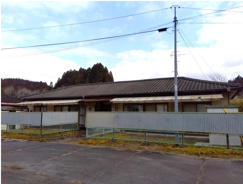
短期滞在施設 蘇陽3号棟A・B
