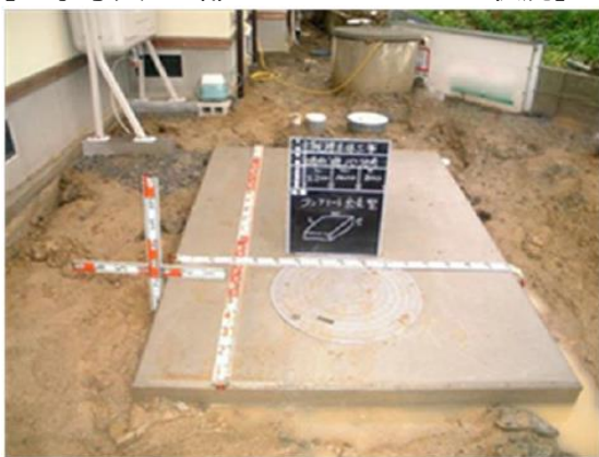
【工事写真 上部スラブコンクリート状況】
