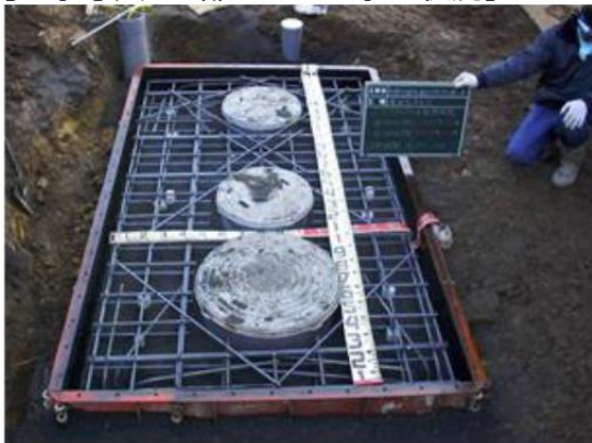
【工事写真 上部スラブ工事の状況】
