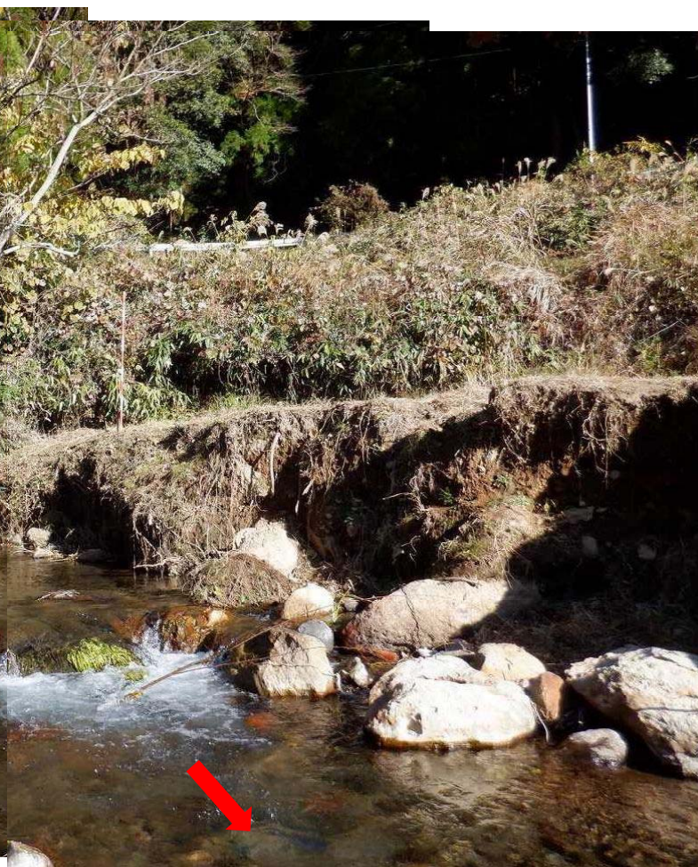
(7工区 左岸) 横断写真 NO.5+10.0
