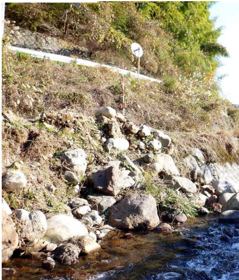
(3工区 左岸) 横断写真 NO.0+19.9
