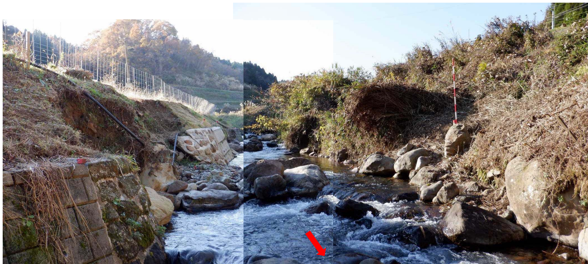
(3工区 左岸) 横断写真 NO.3+7.9
