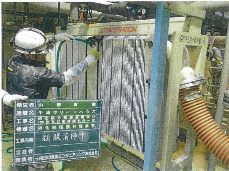
硝化脱腥膜分離装置A号
