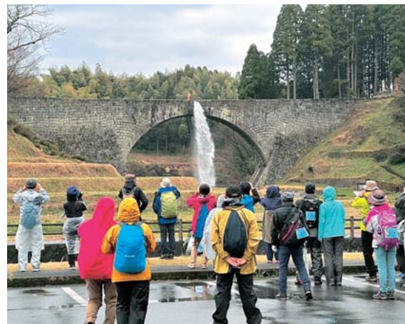
通潤橋特別放水の様子
