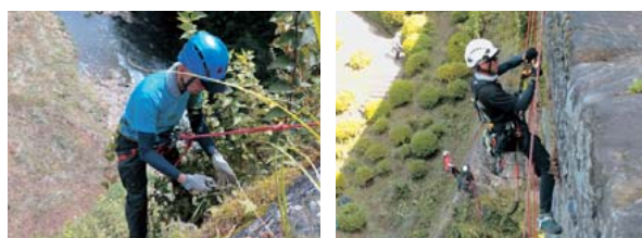
通潤橋除草作業の様子
