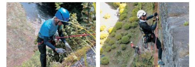
通潤橋除草作業の様子
