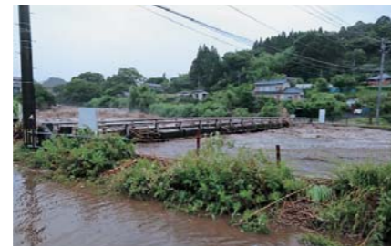
通潤橋芝生広場付近 建設課 ☎ 72-1145
