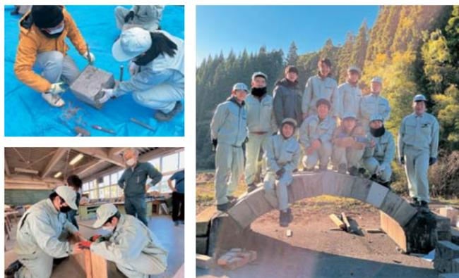
林業科学科では「石橋」の歴史と文化、施工技術を学び、進路の選択として建築や土木、石工を志す生徒の育成を目的に、ものづくりマイスターの派遣による実技指導『継承後の石工』を毎年実施しています。地元の尾上建設さんや、マイスターの山下さん、藤原さんのご指導の下、模型、支保工を使った組み立て、要石の作成を行いました。最終日には11名それぞれが苦勞して削った要石を中心部分にはめ込み、頑丈かつ強固な石橋が完成しました。これからもこの技術を後世に継承していけるよう頑張っていきます。
