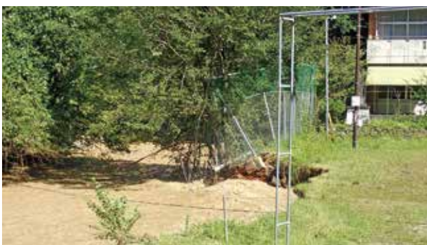
台風被害の様子(清流館)
