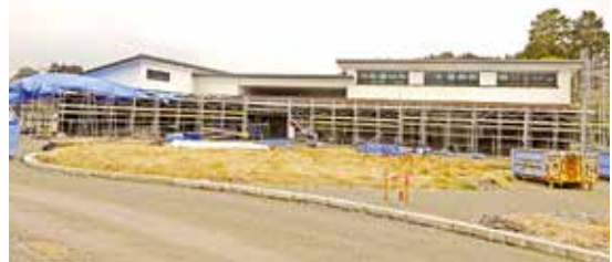
新道の駅の全景(工事中)
