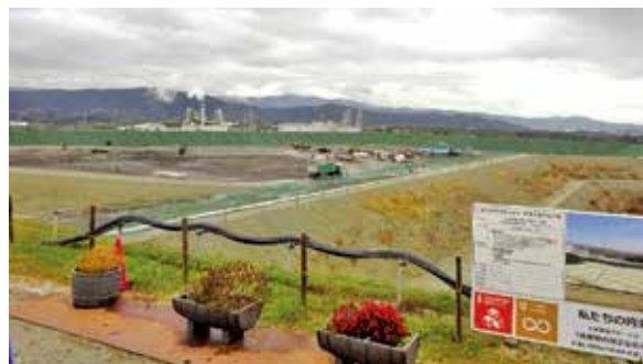
管理型最終処分場の現場
