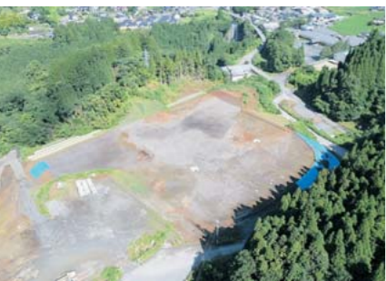
体育館建設地 (令和4年7月現在)
