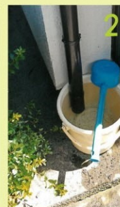
その下にバケツを設置
