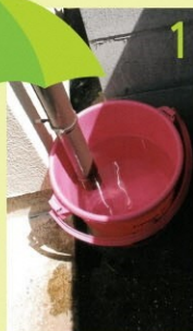
雨どい(塩化ビニール管)の下の配管を外す
