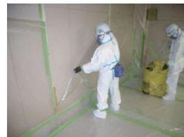
養生シートの撤去
