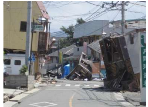
地震で損壊した建物
