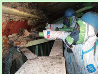
吹付け石綿の除去作業の様子
