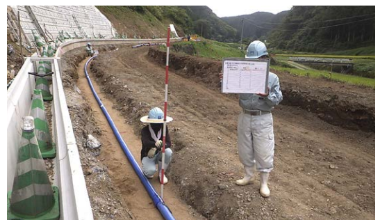
管路工事の様子
