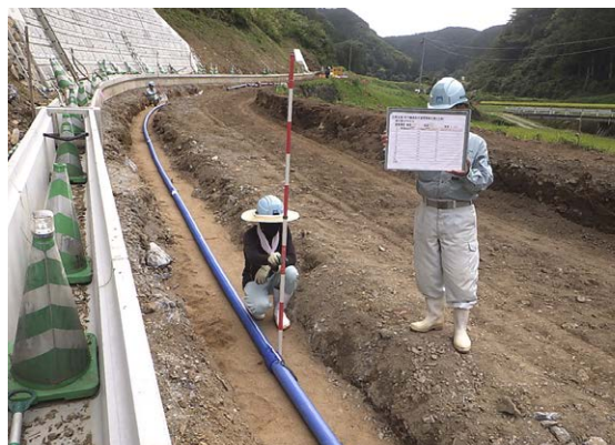
管路工事のようす
