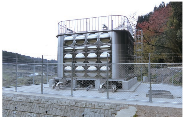
下名連石(川島)配水池
