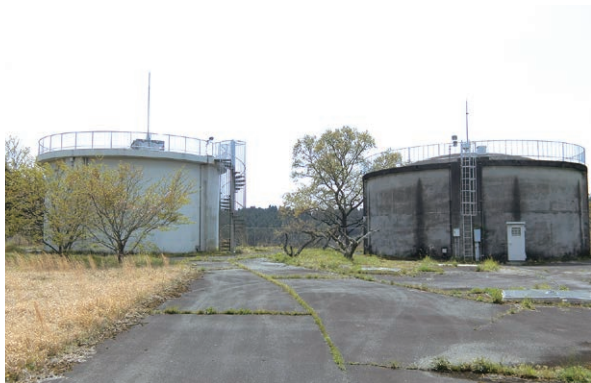
芦屋田配水池
