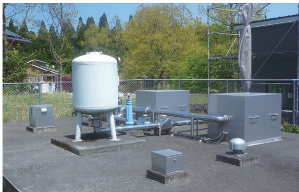
尾野尻加圧所兼配水池
