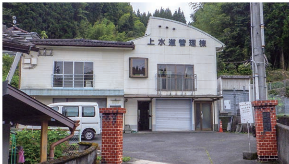
第1水源地管理棟
