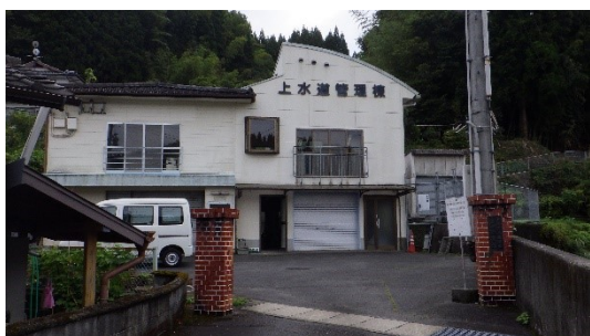
第1水源池管理棟
