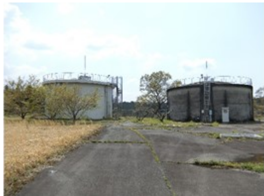
芦屋田配水池
