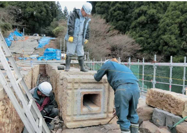
写真1 通水石管の据え直し状況（令和2年1月6日撮影）
